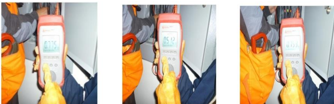
Figura 8. Medición de aislamiento de conductor del pabellón de Secretariado Ejecutivo
