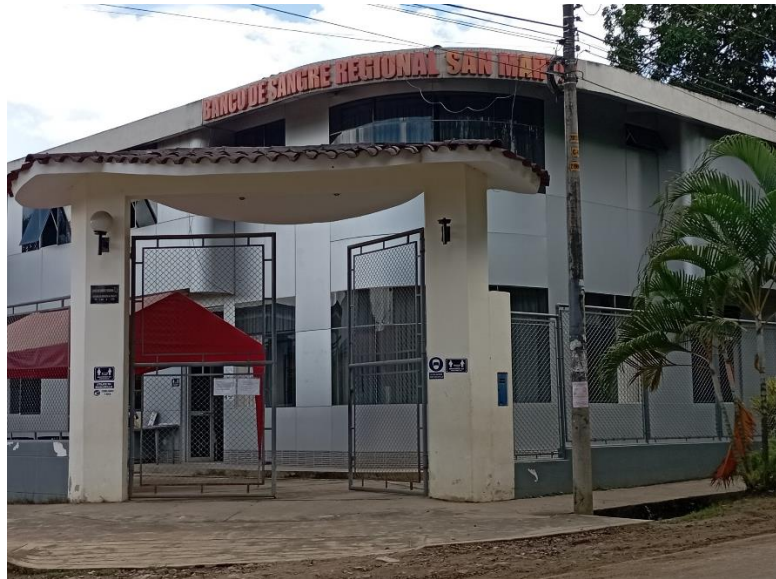
Figura 1. Fachada del hospital
