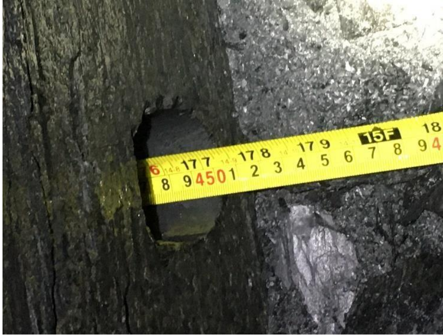
Figura 12. Control de medida de la longitud efectiva de perforación
