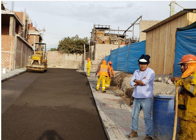
*Figura 15.* Actividades correspondientes a extendido, nivelación conformación de base.
