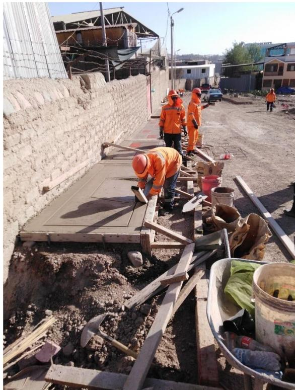
*Figura 25.* Concreto en veredas con  $F_c=175 \text{ Kg/cm}^2$ .
