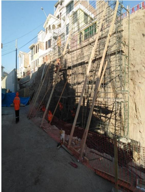
*Figura 22.* Colocacion e izado de acero para muro de contencion.
