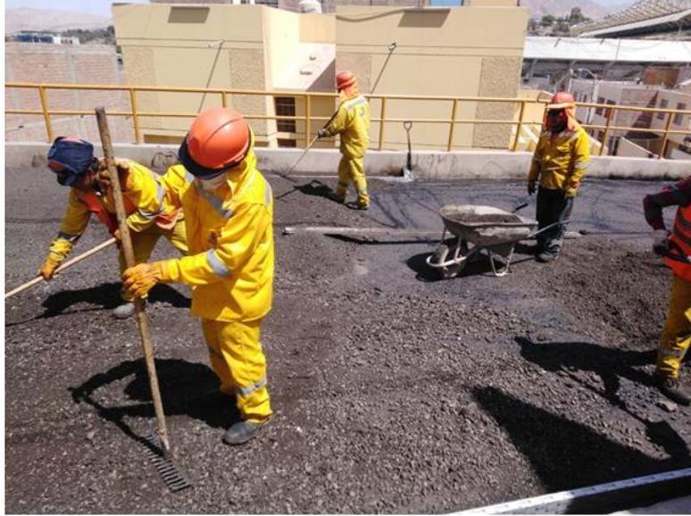
*Figura 14.* Actividades correspondientes a extendido de material bituminoso y asfalto.
