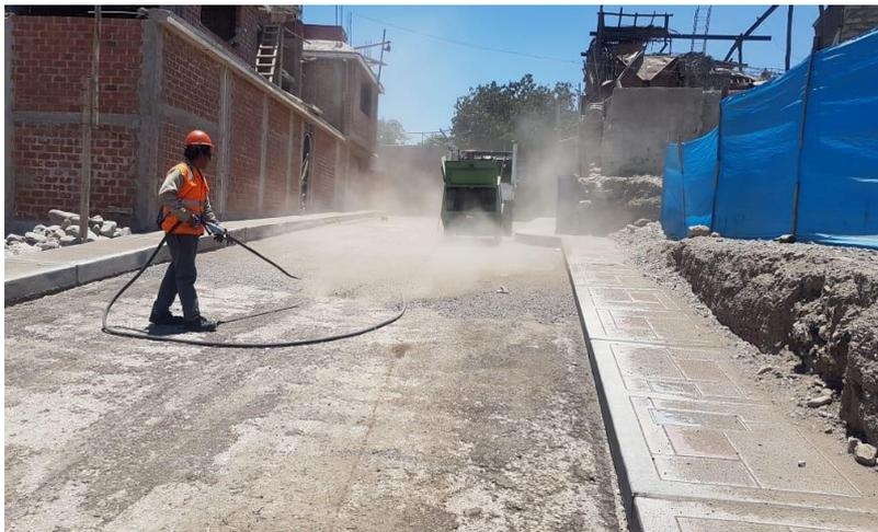
*Figura 17.* Retiro de arenado de vía, para posteriormente conformar con asfalto de 2'' de espesor.
