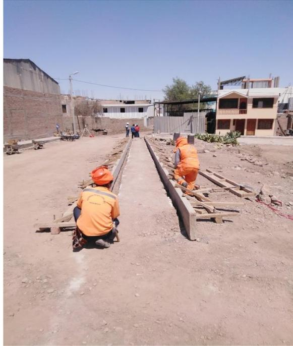
*Figura 24.* Encofrado de veredas y elementos colindantes del pavimento.
