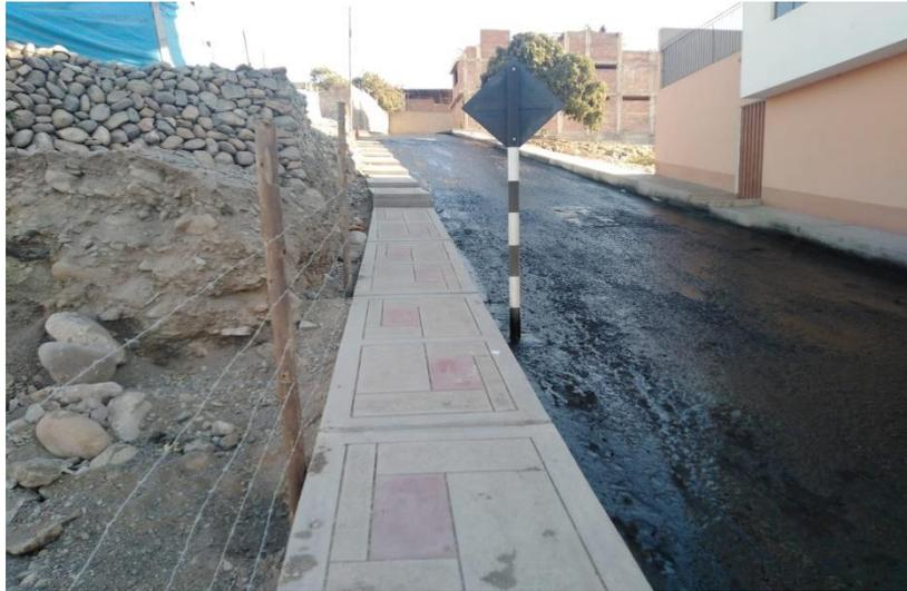
*Figura 18.* Conformación de vía con mezcla bituminosa y riego de liga.
