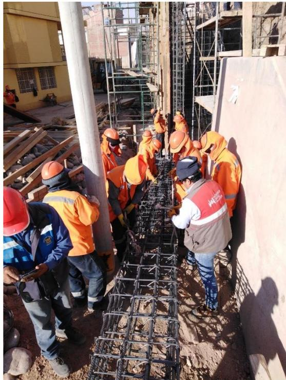
*Figura 21.* Colocación e izado de acero para muro de contención
