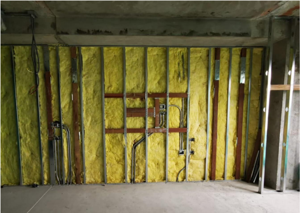
Foto 9. Canalizado de tuberías emt y cajas de f°g° en tabiquería de drywall.
