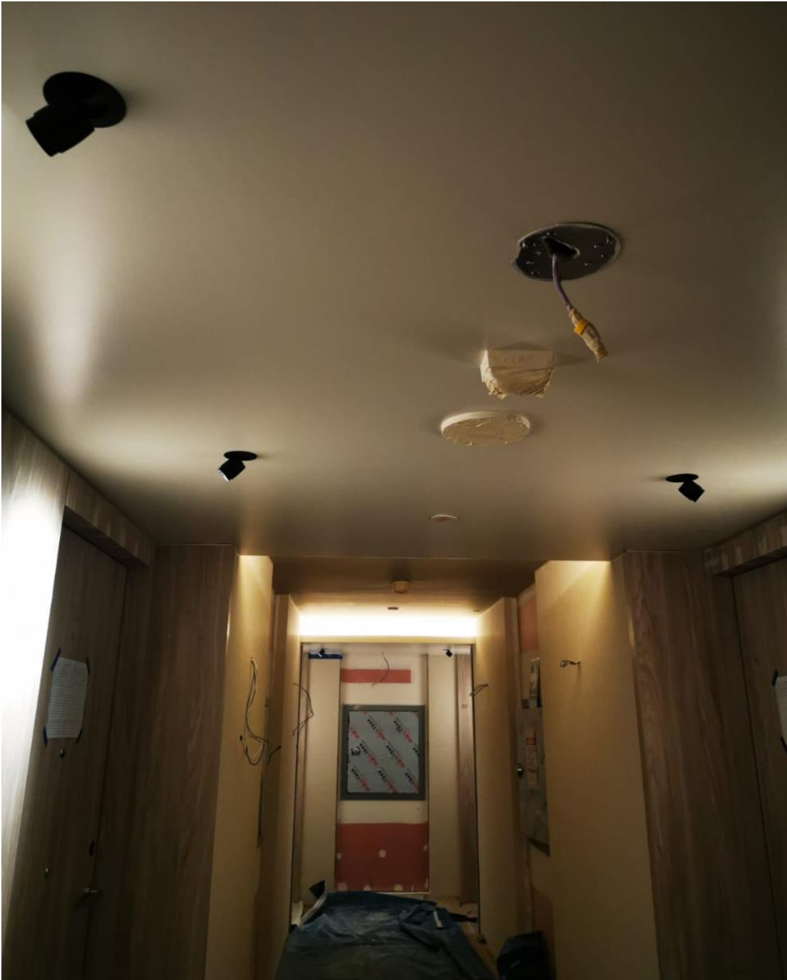
Foto 19. Instalación y prueba de operatividad a accesorios del corredor de habitaciones nivel 3 al 16
