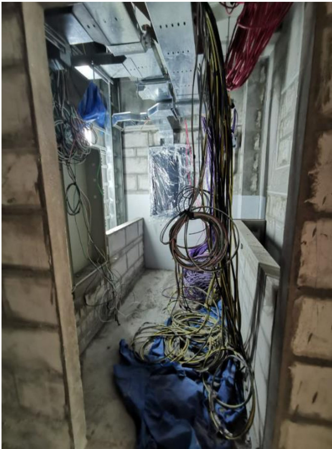
Fuente: Archivo fotográfico de la autora – Obra Hotel Iberostar
