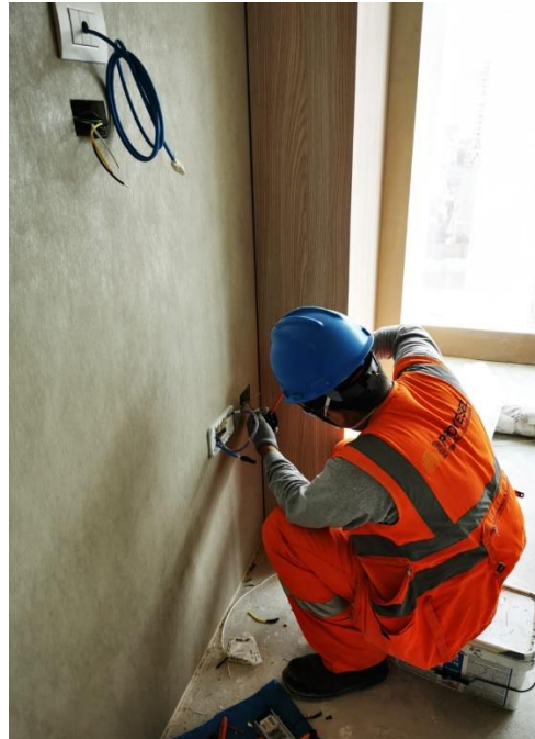
Foto 20. Instalación de accesorios eléctricos en habitaciones
