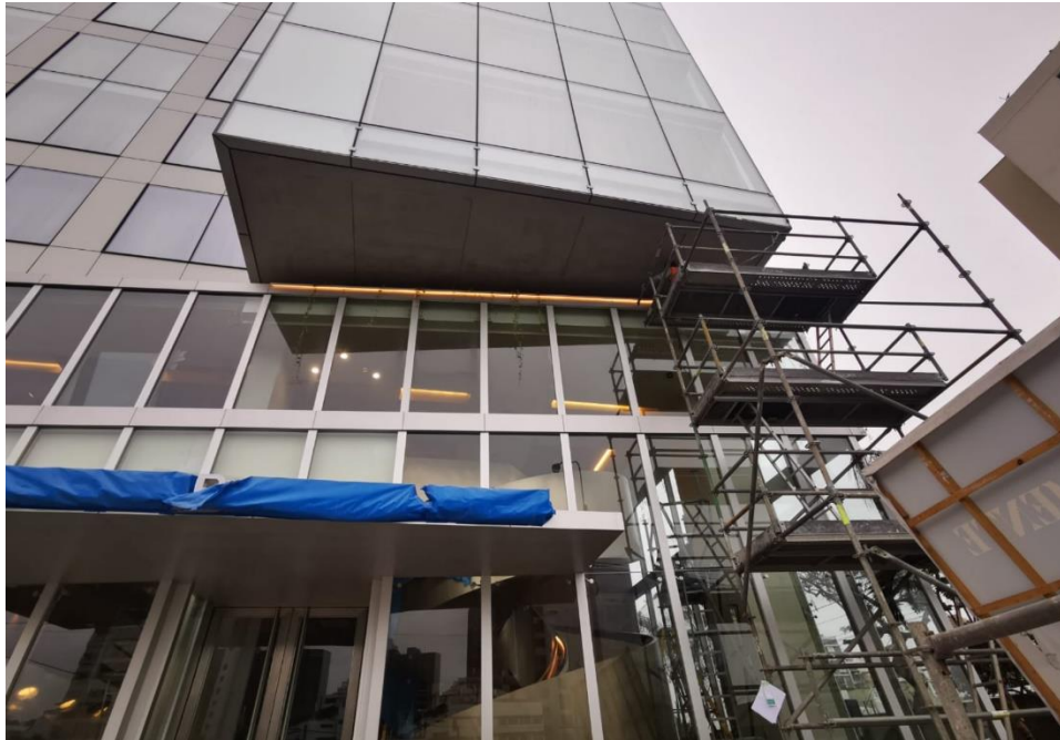
Foto 24. Instalación y prueba de operatividad a accesorios en exteriores
