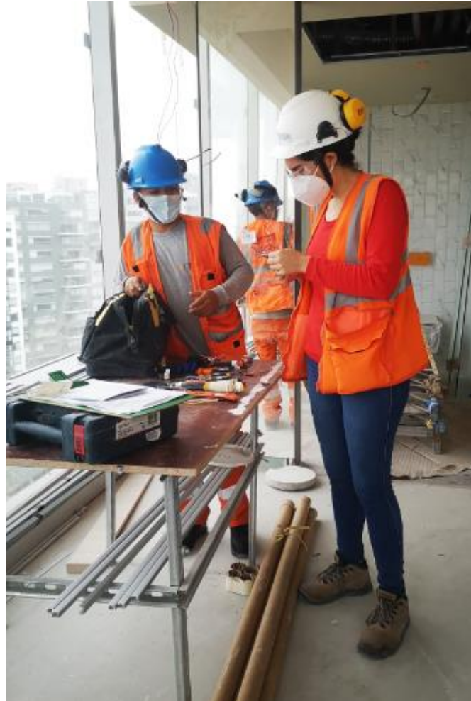
Fuente: Archivo fotográfico de la autora – Obra Hotel Iberostar
