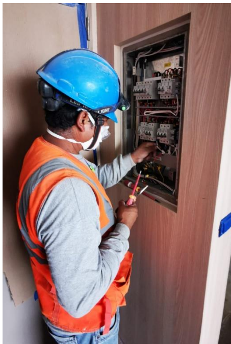
Foto 13. Conexión de circuitos a llaves del tablero y prueba de medida de aislamiento de cables
