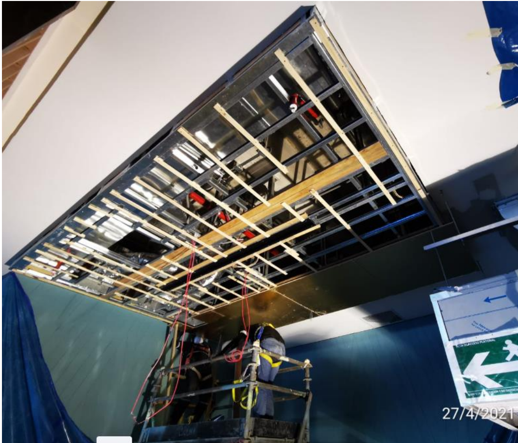
Fuente: Archivo fotográfico de la autora – Obra Hotel Iberostar
