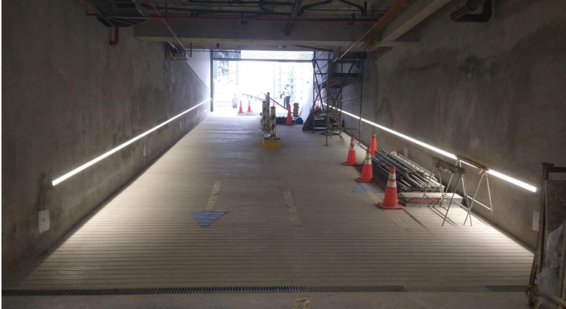
Foto 16. Instalación y prueba de operatividad a luminaria en rampa
