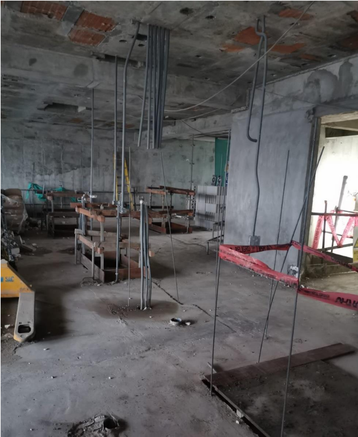
Foto 10. Canalizado de tuberías PVC y cajas de f°g° previo al asentado de bloquetas.
