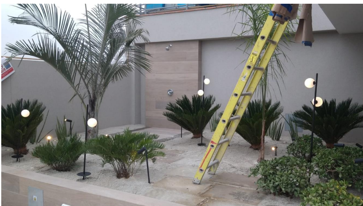
Fuente: Archivo fotográfico de la autora – Obra Hotel Iberostar
