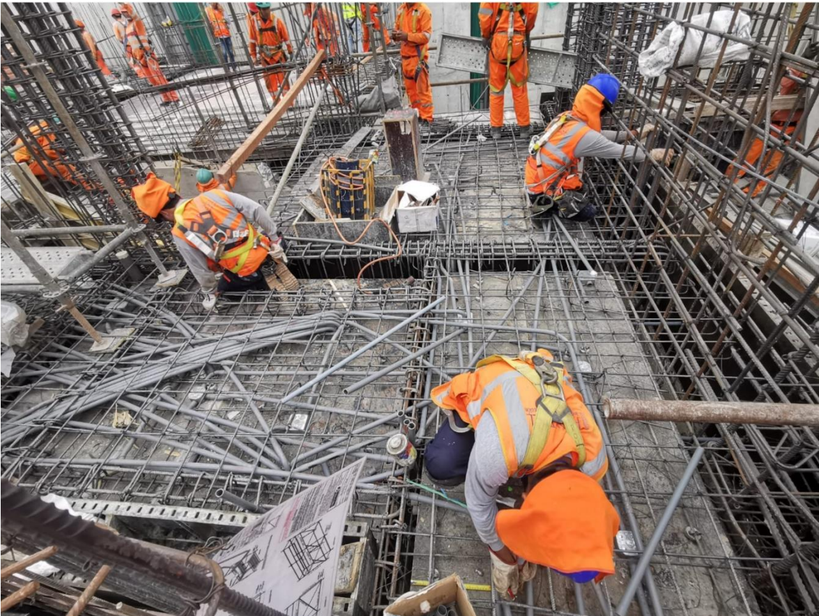
Foto 4. Canalizado de tuberías PVC en losa maciza
