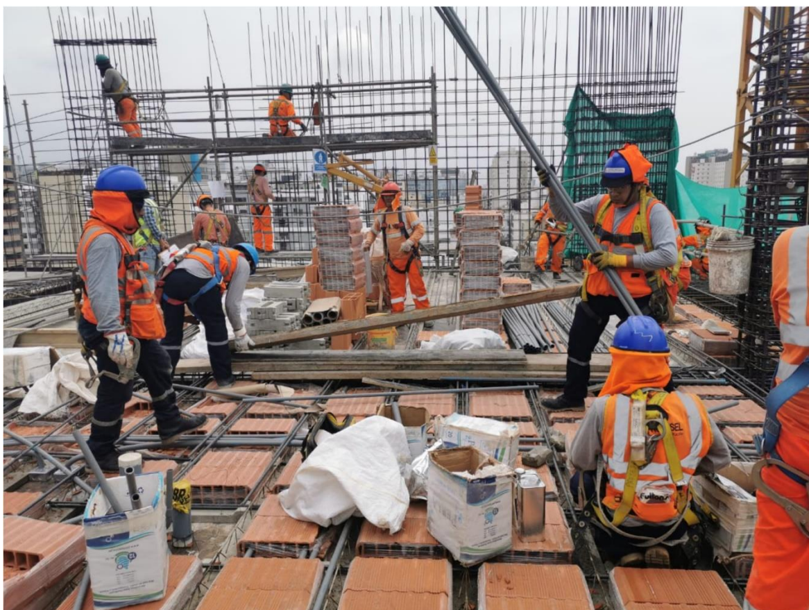
Fuente: Archivo fotográfico de la autora – Obra Hotel Iberostar
