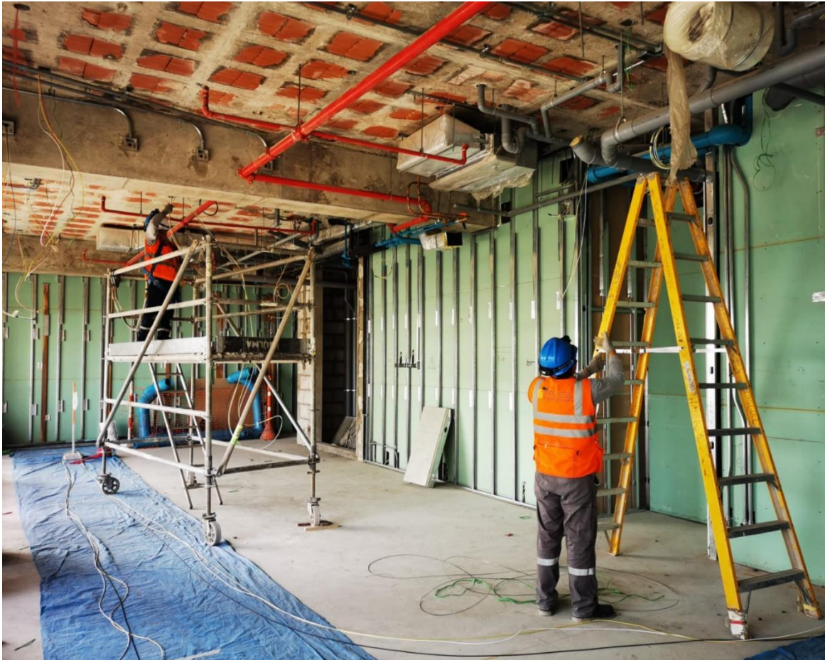
Foto 14. Winchado y cableado de circuitos
