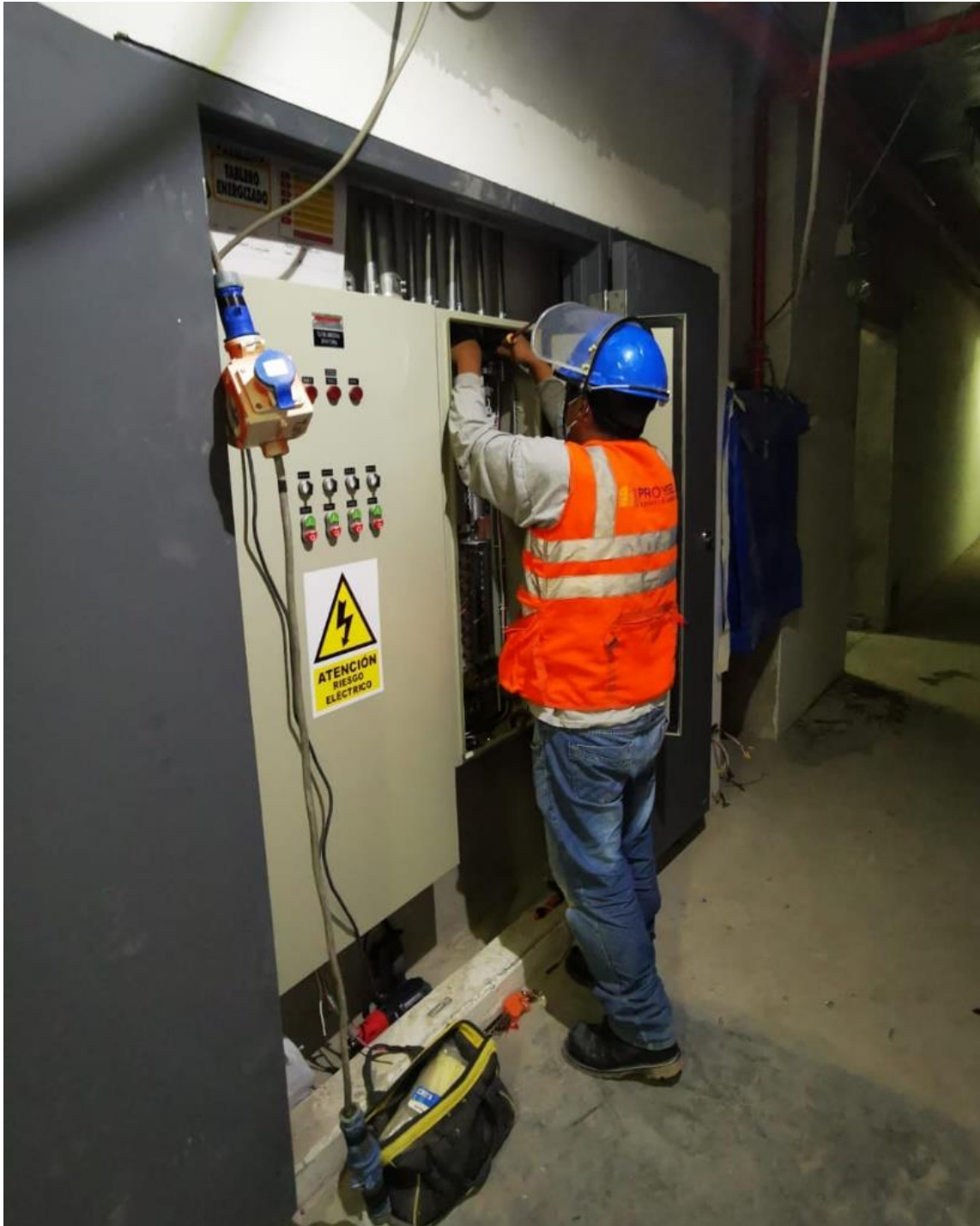
Foto 12. Instalación de tableros adosados de distribución
