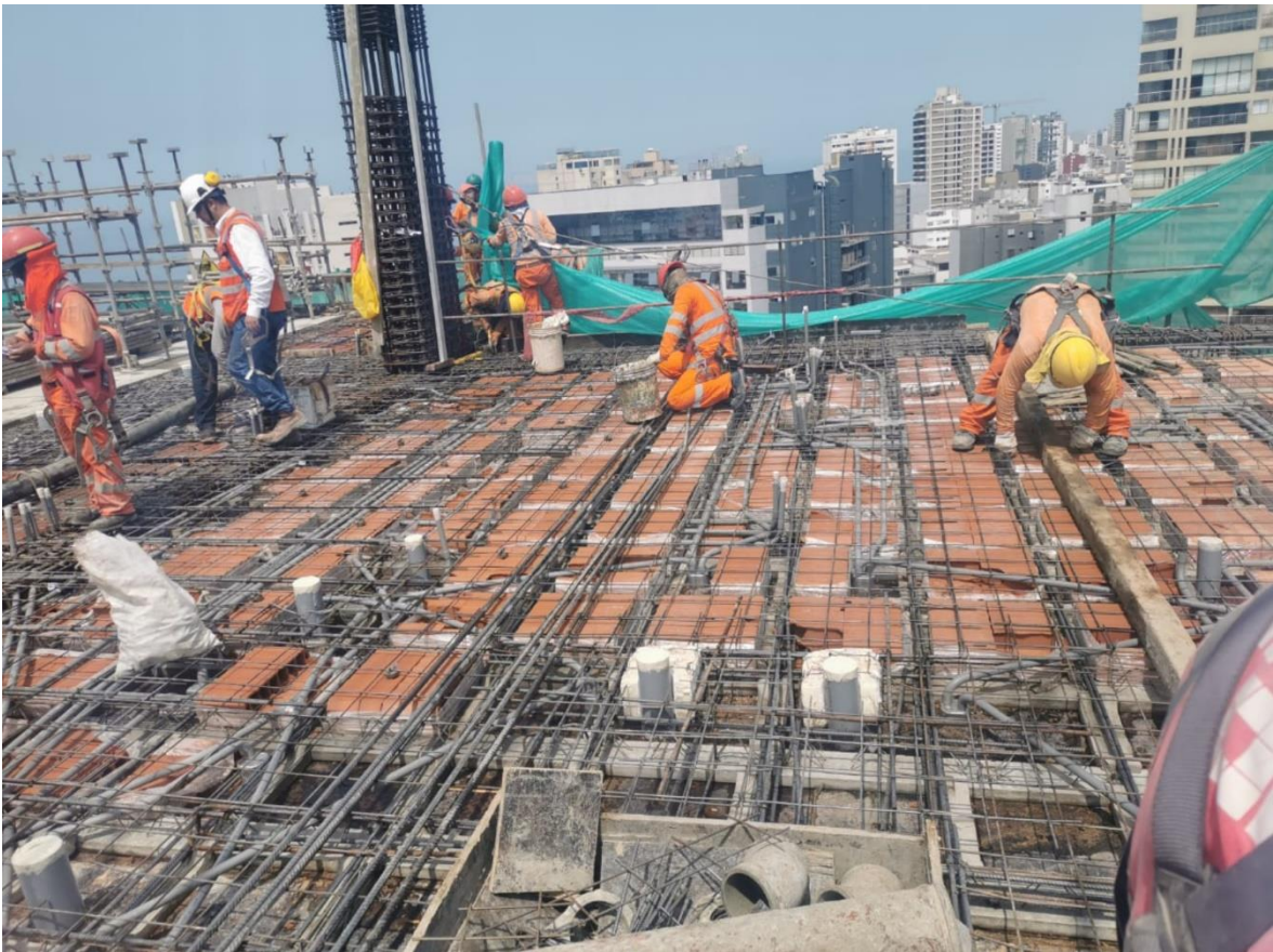
Foto 3. Canalizado de tuberías PVC en losa aligerada
