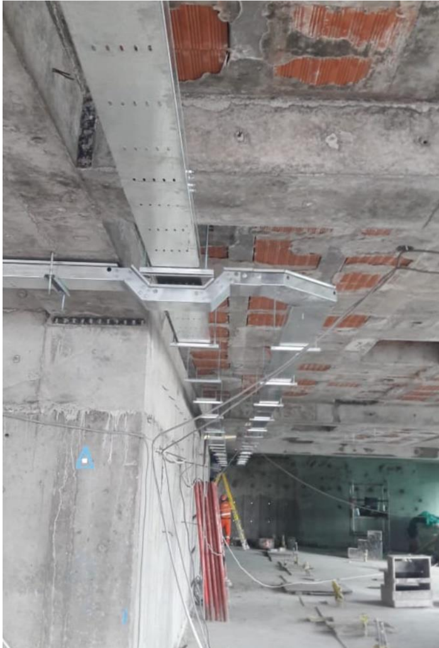
Foto 15. Instalación de bandejas porta cable tipo ranurada en corredores
