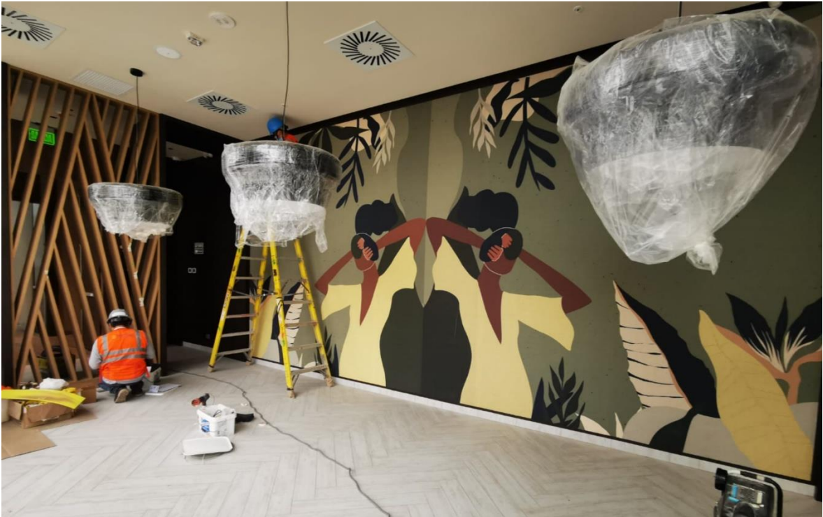
Foto 17. Instalación y prueba de operatividad a accesorios en nivel 1
