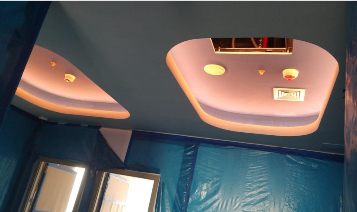
Foto 22. Instalación y prueba de operatividad a accesorios del nivel 17
