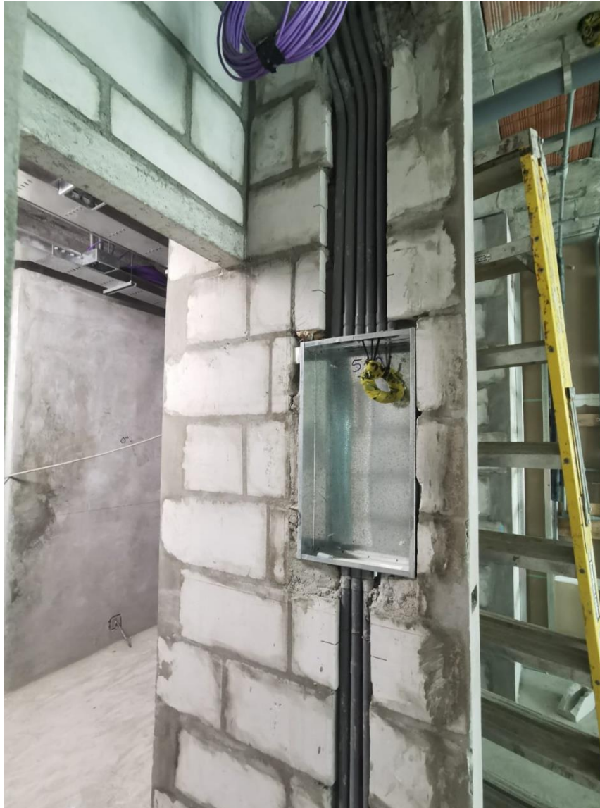
Foto 11. Instalación de gabinete de tablero de habitaciones
