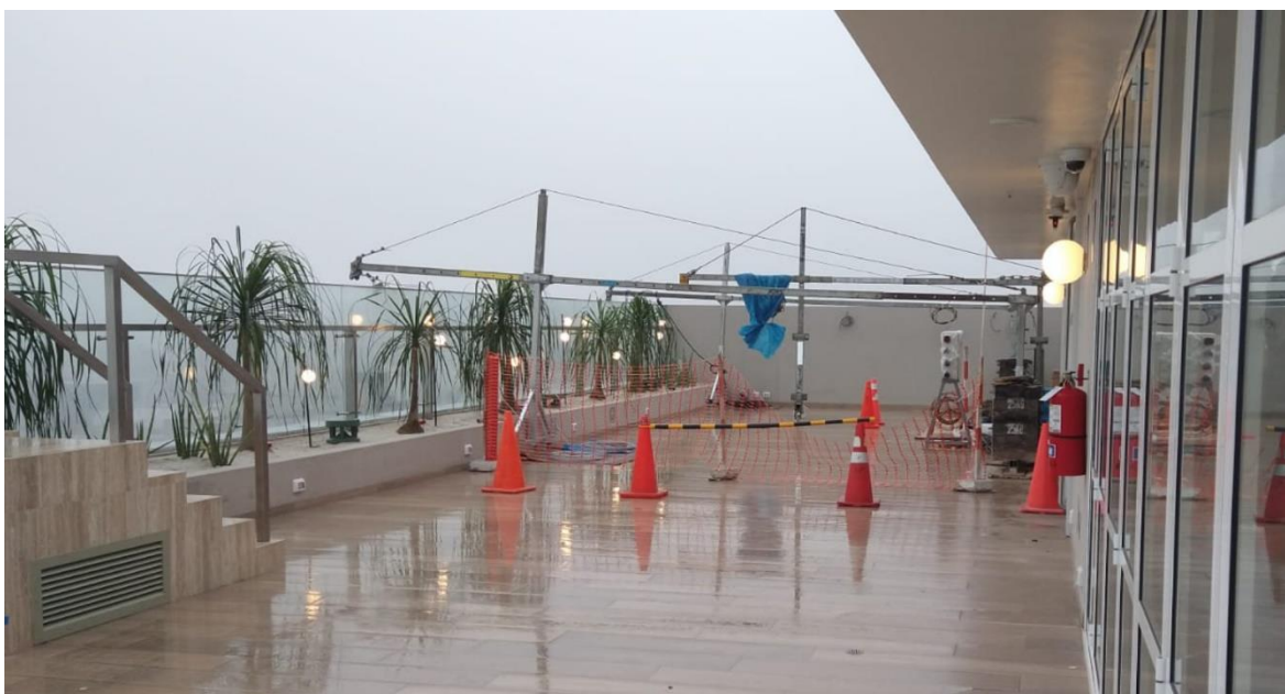
Foto 23. Instalación y prueba de operatividad a accesorios de Azotea
