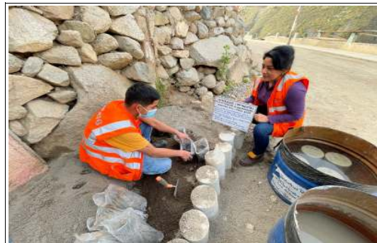
Foto 24. Colocación de moldes de suelo cemento en camara humeda para el curado de las probetas
