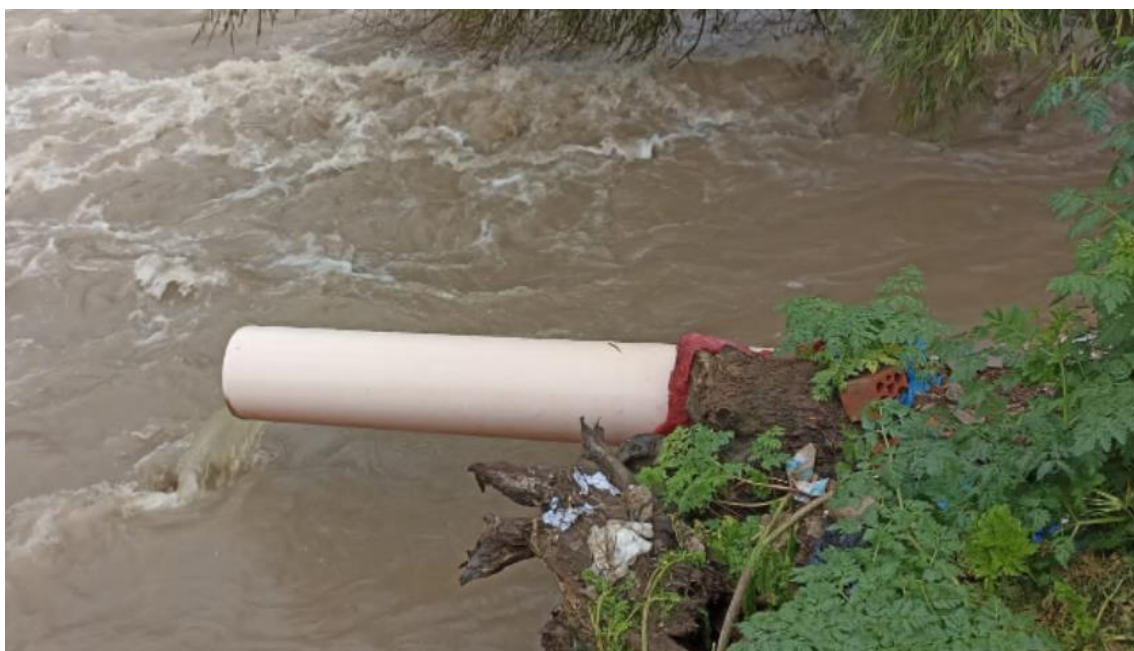
Se muestra la descarga de agua residual en el cuerpo receptor (río Vizcarra).
