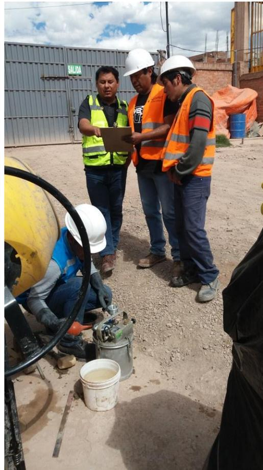
**Foto 8.** *Proceso de moldeado y control de briquetas del concreto patrón y reciclado de  $f''c = 210 \text{ kg/cm}^2$  con agregado grueso reciclado en la planta Conarena – Cusco*
