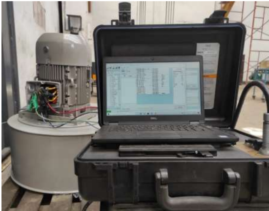
Figura 34. Pruebas Eléctricas a Motor (a).
