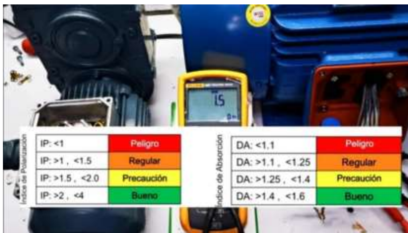
Figura 37. Prueba de megómetro IP y DAR. Fuente: Empresa SELCAF S.A.C.
