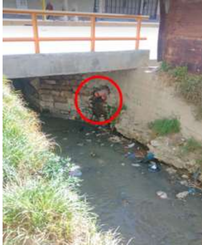
Figura 5. Tubería de descarga de aguas residuales de la Av. Real.
