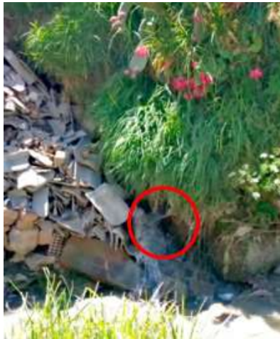
Figura 6. Tubería de descarga de aguas residuales del Pje. Orellana.
