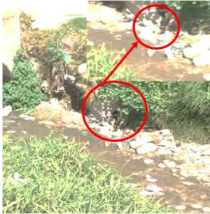
Figura 3. Tubería de descarga de aguas residuales de la Calle Amazonas y Manco Cápac.
