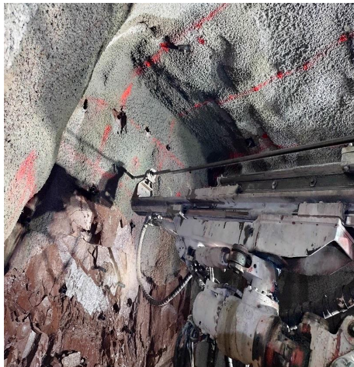
Figura 32. Perforación con barra de 16 pies
