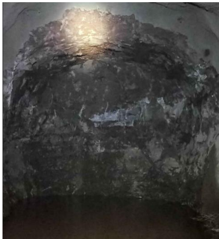
Figura 34. Resultados de la voladura ya percutada
