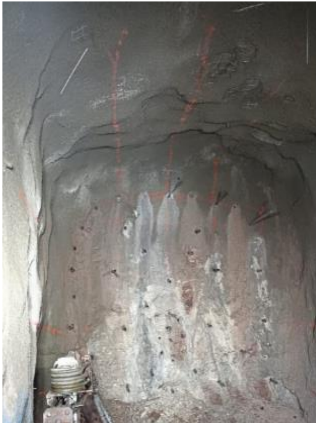
Figura 30. Frente perforados con taladros de alivio
