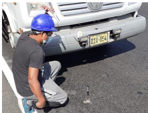
Toma de Temperatura de la capa asfáltica
