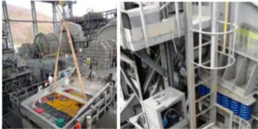
**Figura N°14.** Maniobra de Izaje de la Zaranda Vibratoria.
