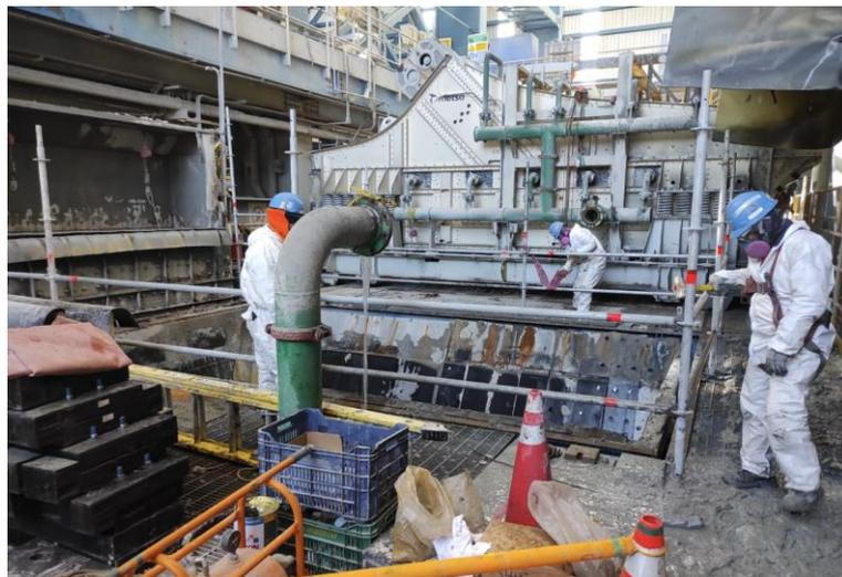
**Figura N°2.** *Zaranda Húmeda, desplazada para realizar cambio de forros de tolva.
