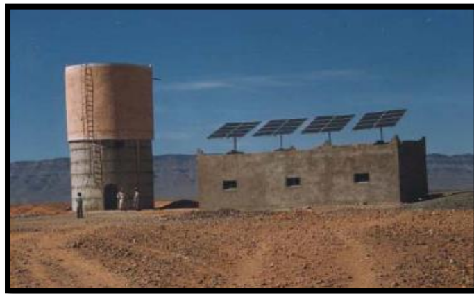
Figura 4. Sistema de bombeo con depósito elevado.
