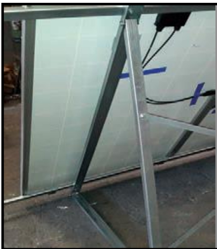
Figura 37. Soportes de un panel solar.
