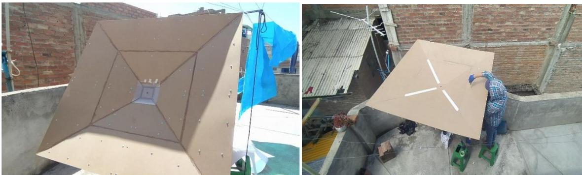
Fotografías que muestran la instalación en campo del cerramiento con mdf de espesor de 3 mm y lámina plástica de 8 micras sellados a su vez con silicona incolora.
