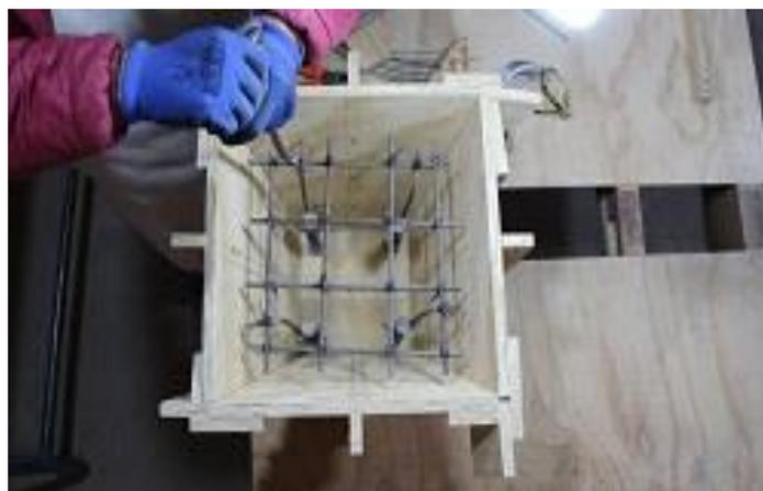
Fotografía que muestra el tejido de acero de 1/4" en el encofrado para la base de hormigón armado.
