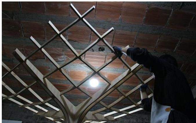
Fotografía que muestra el ensamble del segundo grupo de piezas que conforman la trama estructural.
