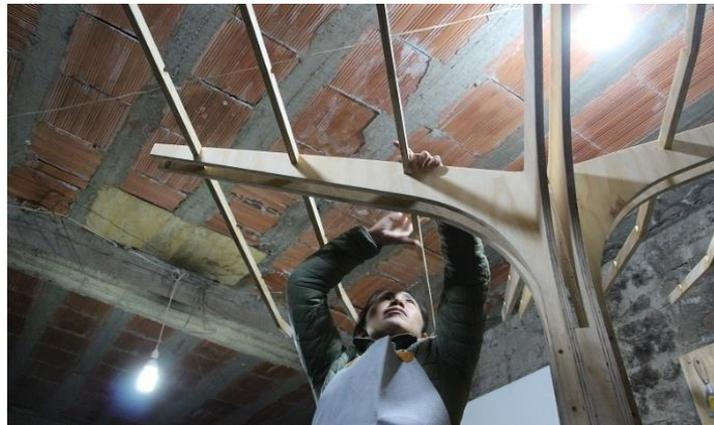
Fotografía que muestra los ensambles del primer grupo de piezas que conformaran la trama estructural.
