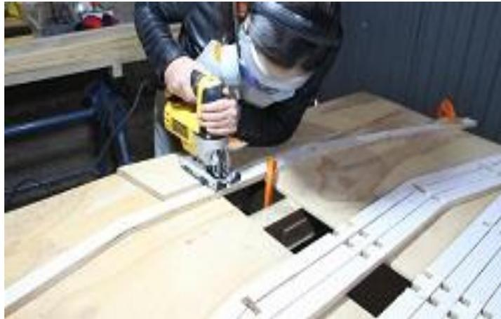
Fotografía que muestra los cortes a detalle para el encaje de las piezas de la trama estructural
