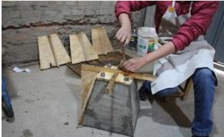
Fotografía que muestra el desencofrado de la base de concreto armado.
