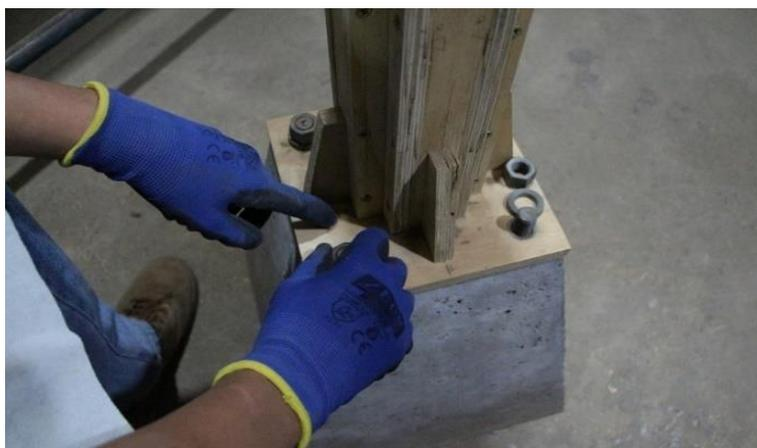
Fotografía que muestra el ensamble del soporte hacia la base de hormigón armado empleando espárragos, tuercas y arandela de acero de 1/2".
