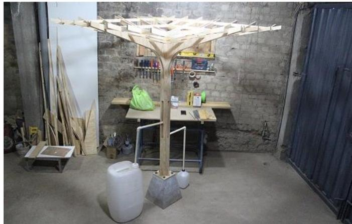
Fotografía que muestra una vista general de la cubierta donde se aprecia la trama estructural, soporte principal, base de concreto y sistema de captación pluvial.
