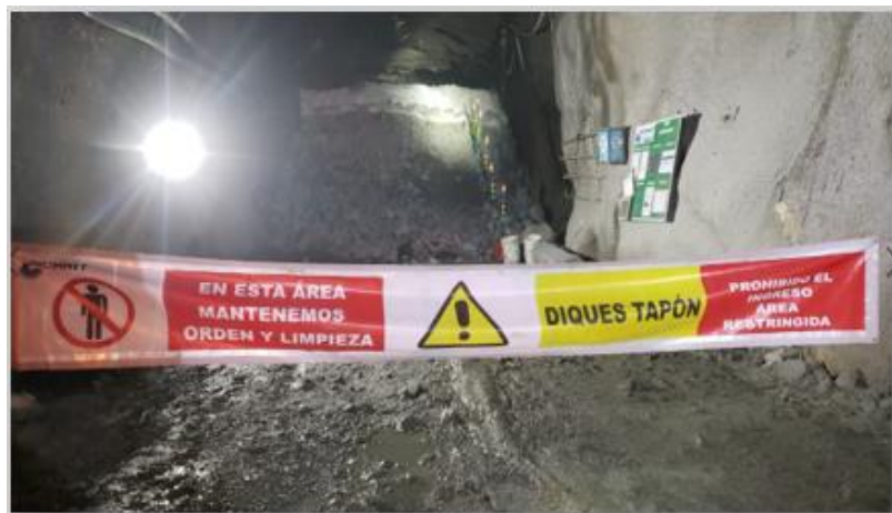
Figura 22. Área de seguridad del dique tapón para relleno en pasta
