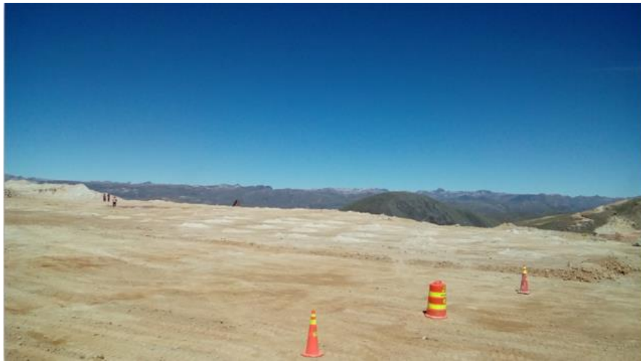
Figura 11. Perforación en el banco 4672 Tomada del departamento de Geología y Planeamiento de la unidad minera Utunsa (6)
