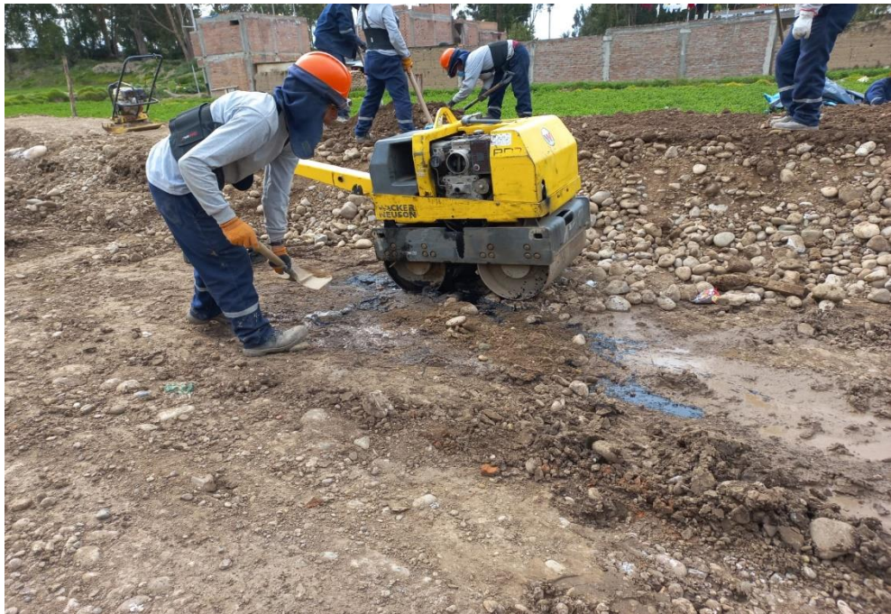
Figura 17. Remediación de zona afectada.
