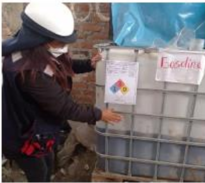
IMAGEN 19: Implementación de Rombos de Seguridad.
