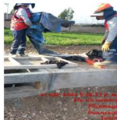
IMAGEN 14: Orden y limpieza en el área de trabajo (desencofrado)
