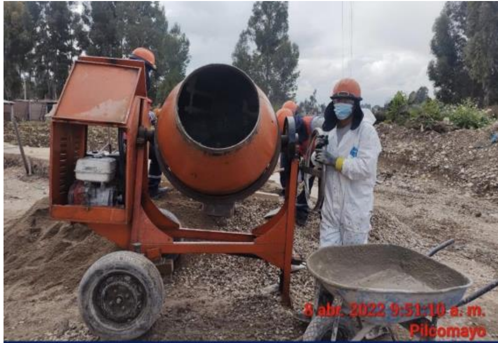
Figura 10. Inspección de equipos.
