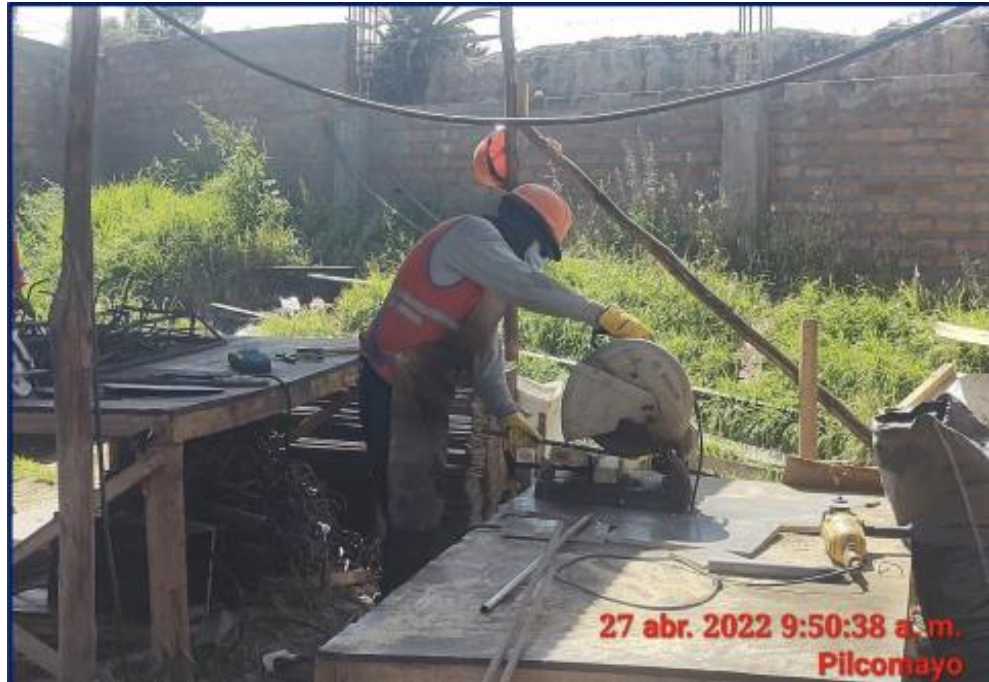
Figura 12. Inspección de equipo eléctrico.
