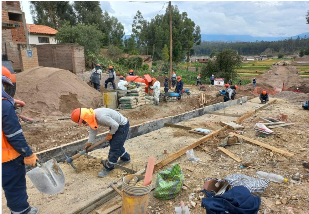
Figura 32. Encofrado de veredas.
