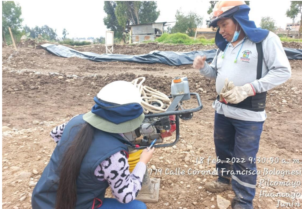
Figura 43. Inspección de equipos.
