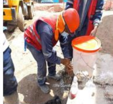
IMAGEN 02: Lavado de manos del personal en obra.
