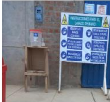
IMAGEN 01: Implementación de señalización uso adecuado de las aguas para el lavado de manos u otros usos del personal en obra.
