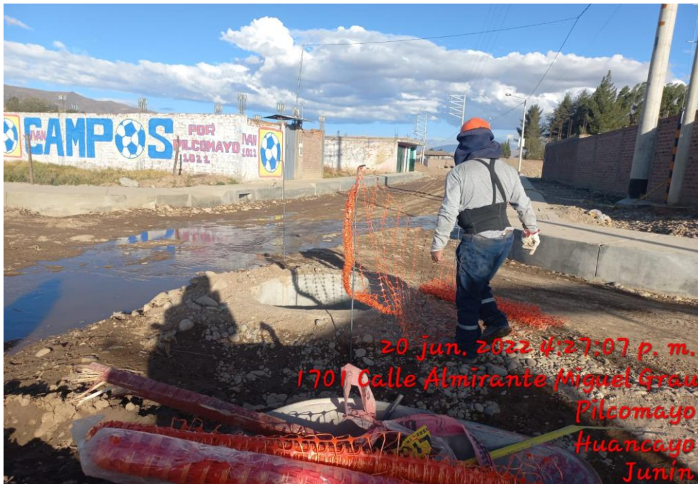
Figura 49. Reemplazar estacas de madera por retazos de fierros.
