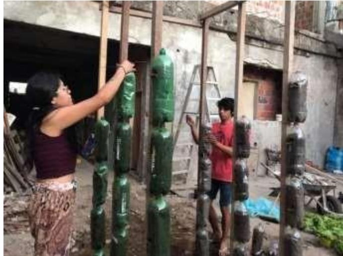
Figura 5. Instalación del sistema vertical
