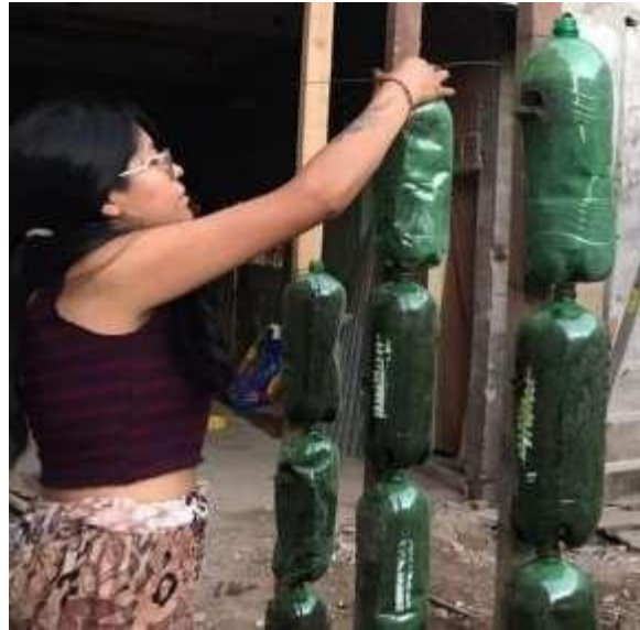
Figura 7. Instalación de los envases PET
