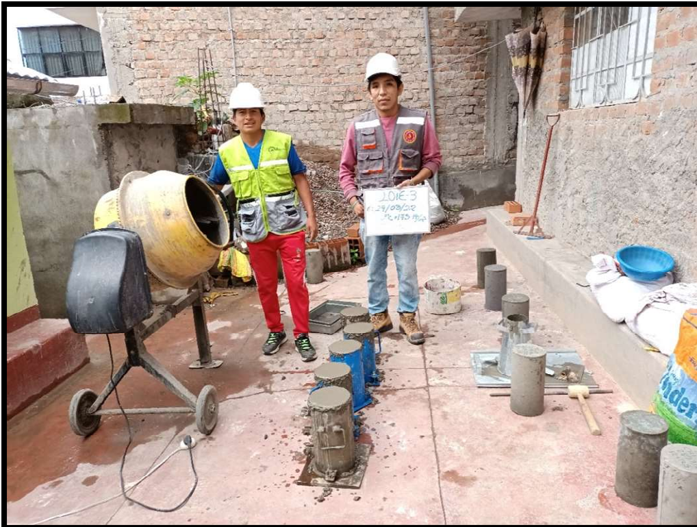
Fotografía 22. Elaboración del Lote 3 de testigos de concreto.
