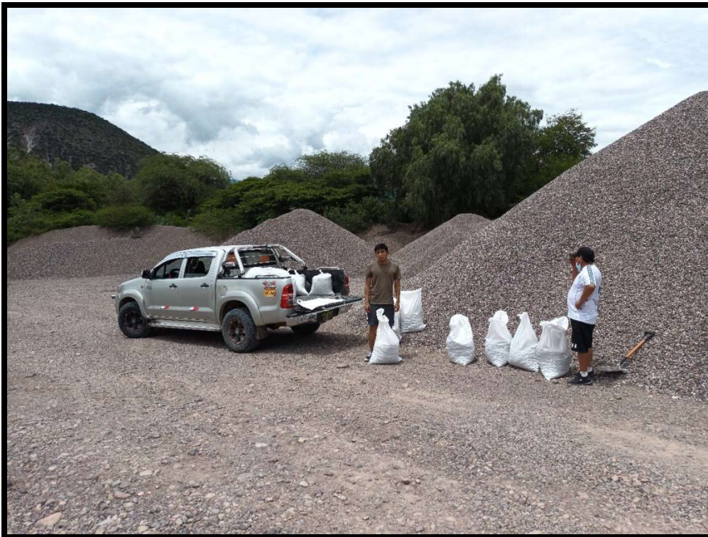
Fotografía 02. Adquisición de agregado grueso de la cantera Chillico
