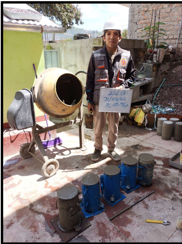
Fotografía 26. Elaboración del Lote 7 de testigos de concreto.
