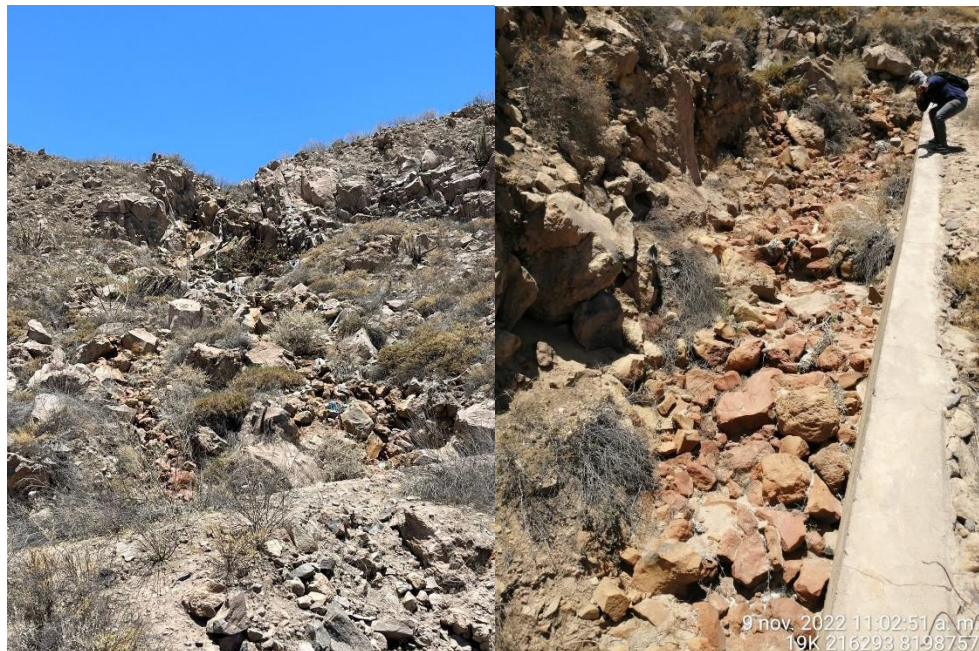
Figura N° 13: Desemboque de lixiviado en Quebrada Honda (Punto N° 2)
