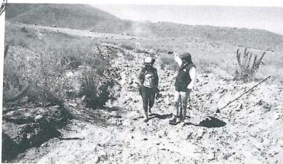
Anexo N° 10: 4N, movimiento de tierra en quebrada afluente a quebrada Honda, de fecha 18.06.2019
