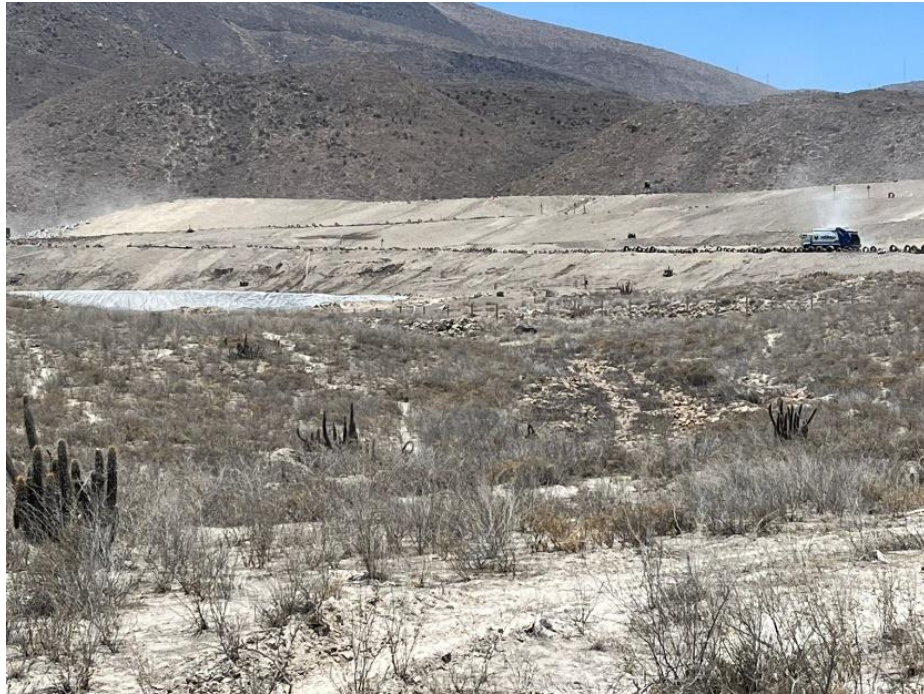
Figura N°12: Canal de rebose por poza de lixiviado (Punto N° 1)
