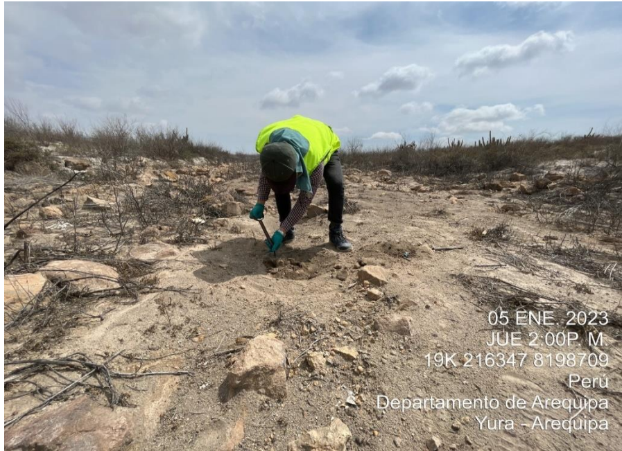
Figura N°21: Excavación del punto N°2
