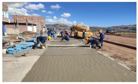
Figura 62: Vista del nivelado y acabado final del concreto fresco en la calzada
