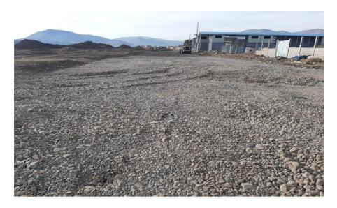
Figura 43: Verificación de la conformación de la capa anticontaminante en el Jr. San Valentín
