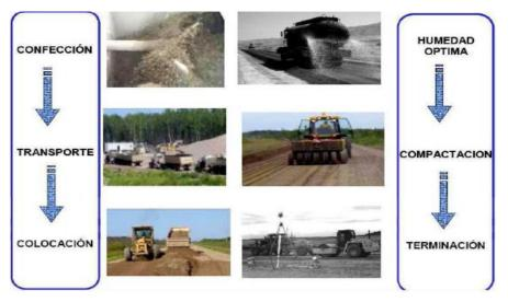
Figura 13: Proceso constructivo de la subrasante y la subbase
