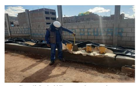
Figura 63: Prueba del Slump y toma de muestras de concreto
