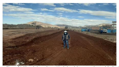
Figura 54: Vista de la conformación de la sub base granular en el Jr. San Valentín
