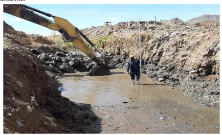
Figura 65:Vista de los niveles y replanteo de la alcantarilla de concreto
