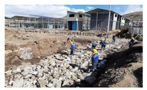
Figura 66:Vista del enrocado de la base de apoyo de la alcantarilla
