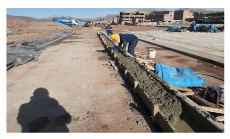
Figura 86: Vista del vaciado del sardinel de separación de la ciclovía y la calzada
