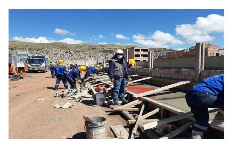
Figura 82: Vista del vaciado y acabado de veredas en el Jr. Dante Nava
