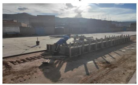
Figura 89: Encofrado de sardinel de protección para áreas verdes
