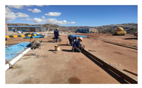
Figura 59: Asegurado de las tablas de madera para el vaciado del concreto
