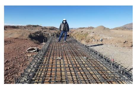
Figura 74: Colocado del acero doble refuerzo en la losa superior de la alcantarilla
