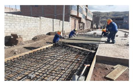
Figura 75: Vista del vaciado de concreto en la losa superior de la alcantarilla
