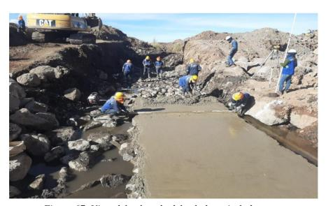
Figura 67: Vista del colocado del solado y nivelado
