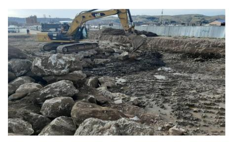
Figura 12: Construcción del pedraplén en el Jr. San Valentín
