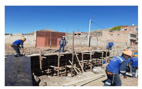
Figura 72: Vista del encofrado de los muros laterales de la alcantarilla
