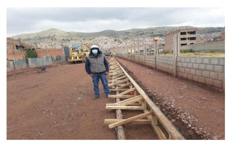
Figura 80: Vista de los encofrados para el vaciado de veredas
