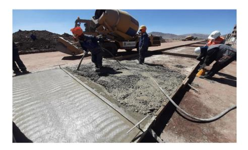
Figura 61: Vista del vibrado de concreto fresco en la calzada
