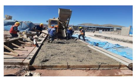
Figura 87: Vaciado de concreto en la ciclovía
