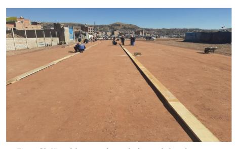
Figura 58: Vista del proceso de encofrado para la losa de concreto
