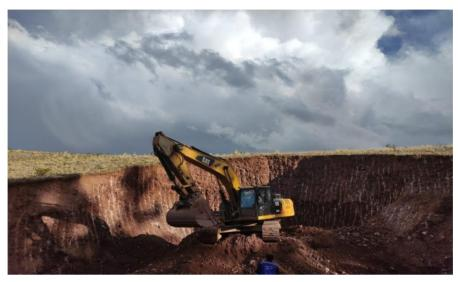
Figura 51: Vista de la extracción y acumulación de material ligante para la subbase
