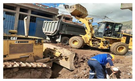
Figura 31: Carguío con maquinaria de material excedente
