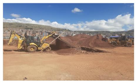
Figura 53: Vista de zarandeo de material ligante para la subbase
