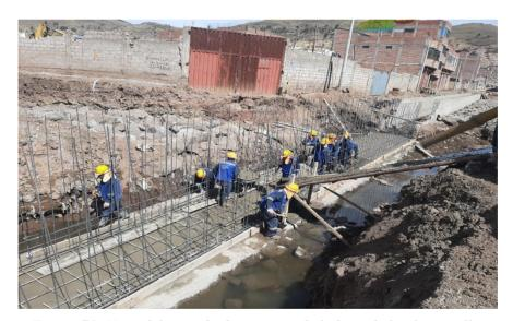
Figura 71: Vista del vaciado de concreto de la base de la alcantarilla
