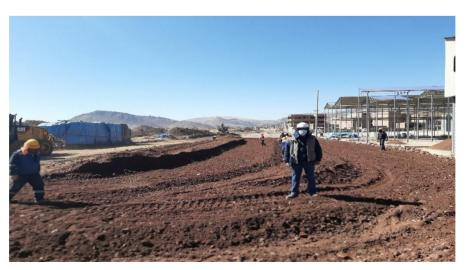
Figura 49: Vista de la conformación de la capa subrasante
