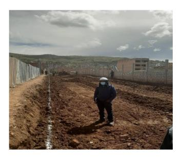
Figura 29: Verificación del corte de terreno con maquinaria
