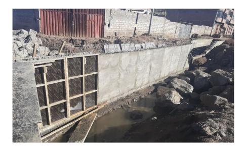
Figura 73: Vista del desencofrado de los muros laterales de la alcantarilla
