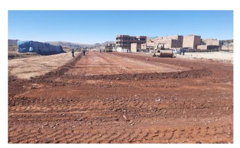
Figura 56: Vista de la conformación de la subbase granular
