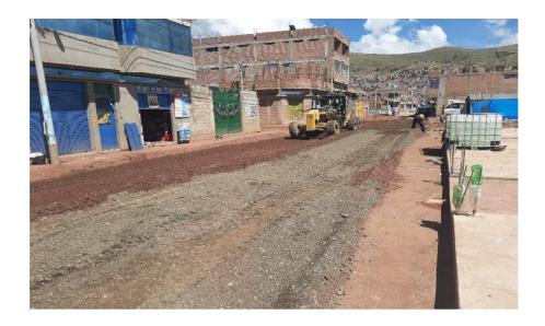
Figura 55: Vista del batido de material ligante con hormigón para la subbase granular en el Jr. Dante Nava
