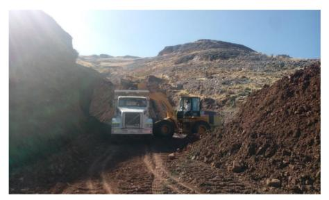
Figura 47: Carguío de material ligante de la cantera Salcedo
