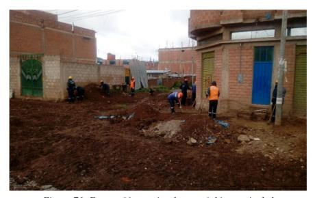
Figura 76: Excavación y retiro de material impropio de la subrasante de la vereda
