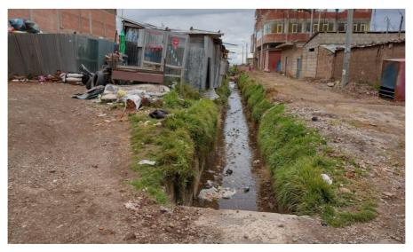
Figura 7: Canal existente sin mantenimiento
