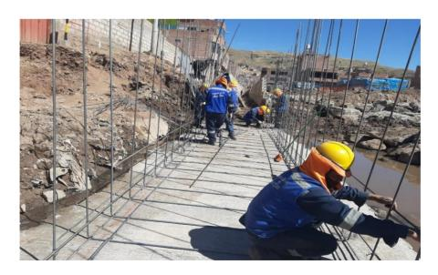
Figura 69: Vista del armado de acero de refuerzo para la alcantarilla
