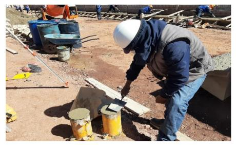
Figura 84: Vista de la toma de muestras de concreto de veredas
