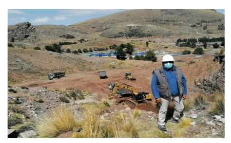
Figura 46: Vista del traslado de material ligante de la cantera Salcedo
