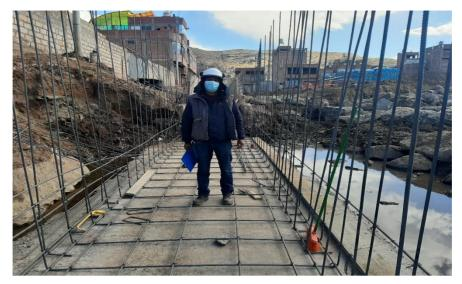
Figura 70: Verificación del colocado de acero de refuerzo
