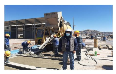
Figura 60: Vista del vaciado de concreto de f'c=210 kg/cm2
