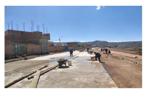
Figura 64: Vista del proceso de curado del concreto
