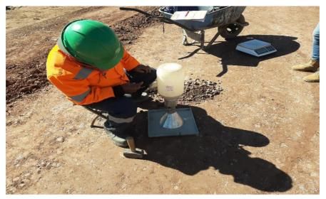
Figura 57: Vista del control de densidad de campo en la subbase
