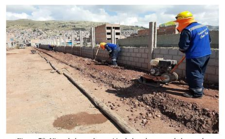
Figura 78: Vista de la conformación de la subrasante de la vereda
