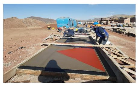
Figura 81: Vista del nivelado y acabado final de las veredas en el Jr. San Valentín
