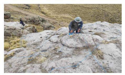
Figura 34: Vista del colocado de la mecha del fulminante
