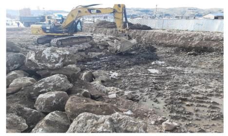
Figura 38: Vista del proceso de conformación del enrocado de cimentación
