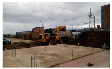
Figura 77: Eliminación de material excedente proveniente de la excavación de veredas
