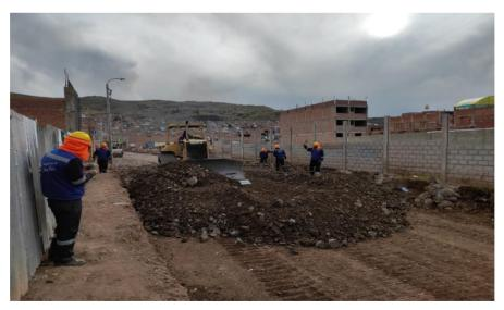
Figura 42: Vista de la conformación de la capa anticontaminante del Jr. Dante Nava
