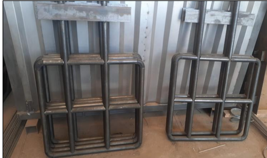
Figura 26. Armado de las barandas de la barcaza
