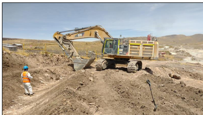
Figura 5. Trabajo de perfilado de la sección del canal
