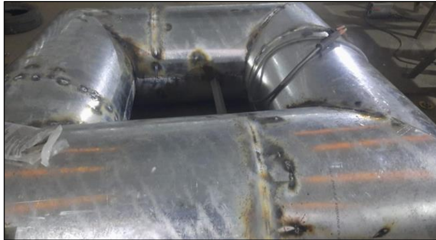
Figura 28. Soldadura de las piezas del flotador
