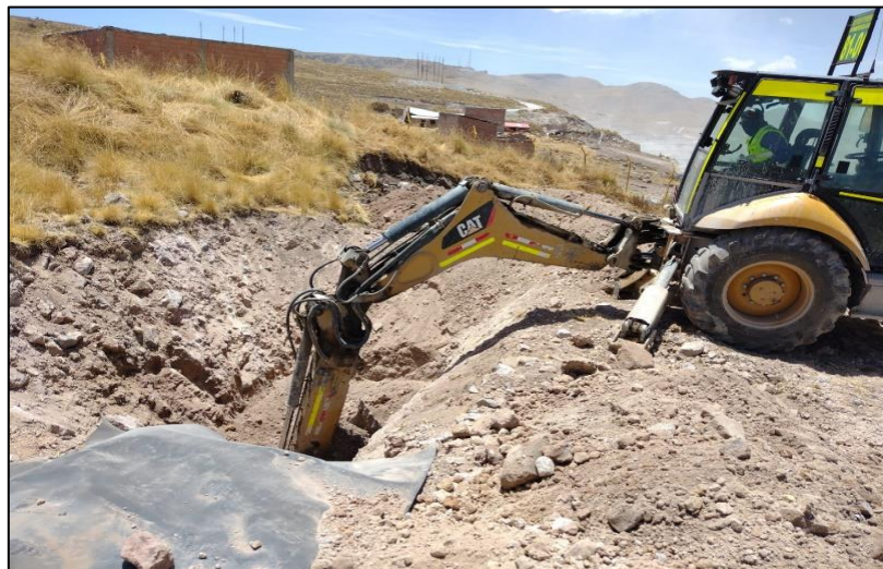
Figura 7. Excavación de la poza con retroexcavadora
