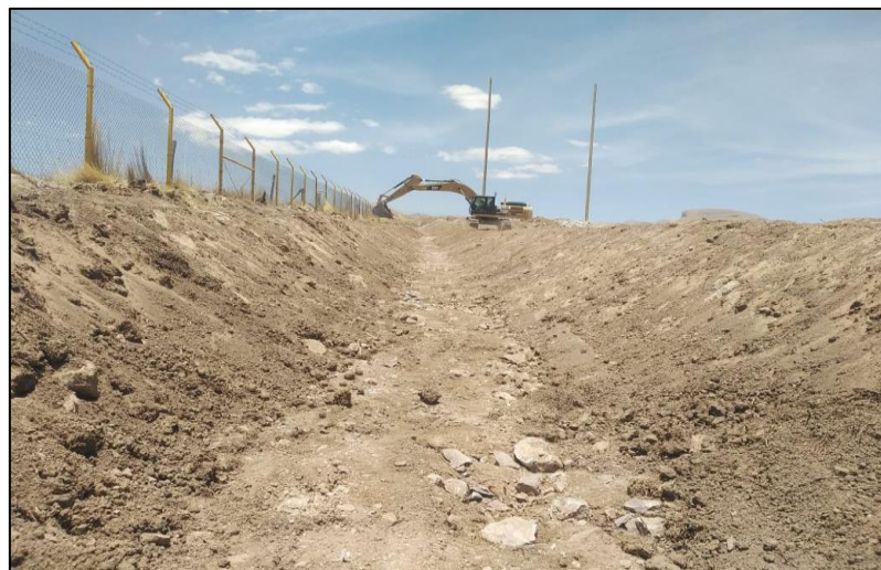
Figura 4. Excavación del canal con retroexcavadora
