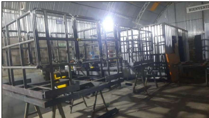
Figura 29. Soldadura de las barandas
