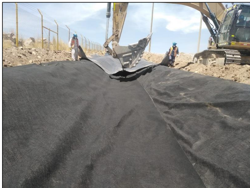
Figura 10. Colocación de las geomembranas sobre el canal
