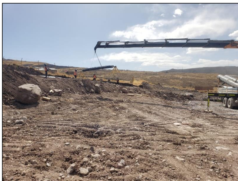
Figura 8. Izaje de las geomembranas para recubrir
