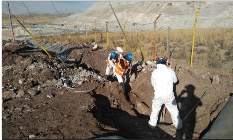
Figura 6. Perfilado manual de la sección del canal
