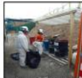
Planta de Filtrado
