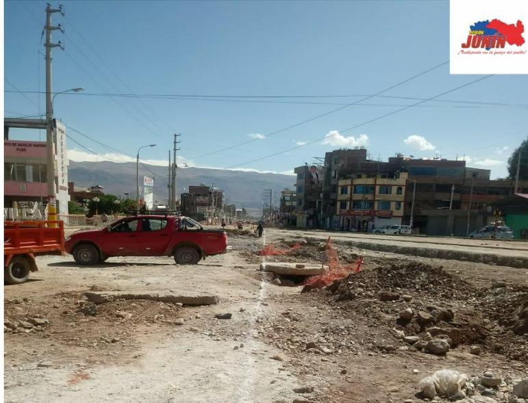
Figura 105. Trazo y nivelación para calzada de pavimento
