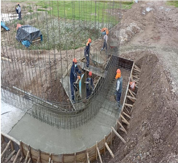
Figura 89. Vaciado de concreto  $f'c=280$  kg/cm<sup>2</sup> en muros de contención
