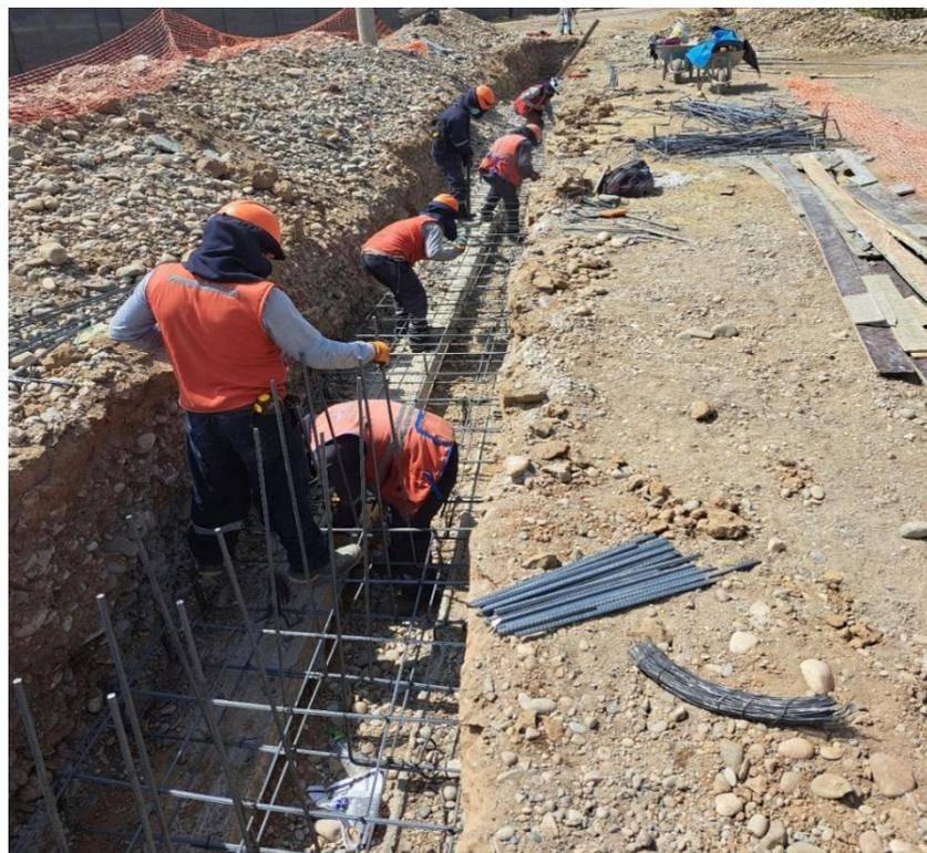
Figura 86. Acero de refuerzo en muro de contención - Av. Circunvalación L.D.
