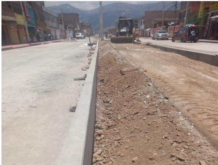
Figura 96. Nivelación y perfilado de ciclovía
