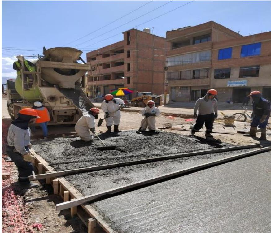
Figura 125. Concreto premezclado  $f'c=350$  kg/cm<sup>2</sup> en pavimento
