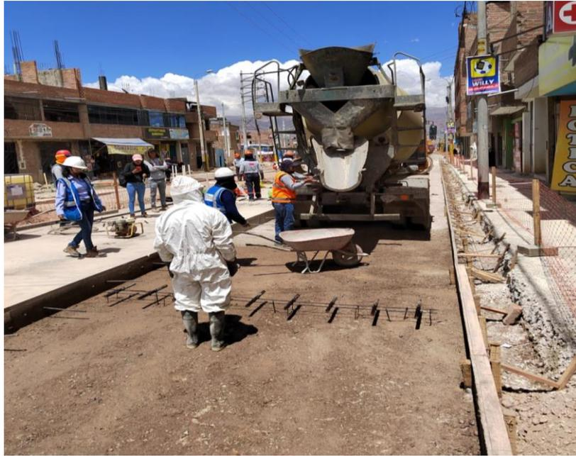
Figura 123. Dowells  $1 \frac{1}{4}$ ” en concreto hidráulico  $f'c=350 \text{ kg/cm}^2$
