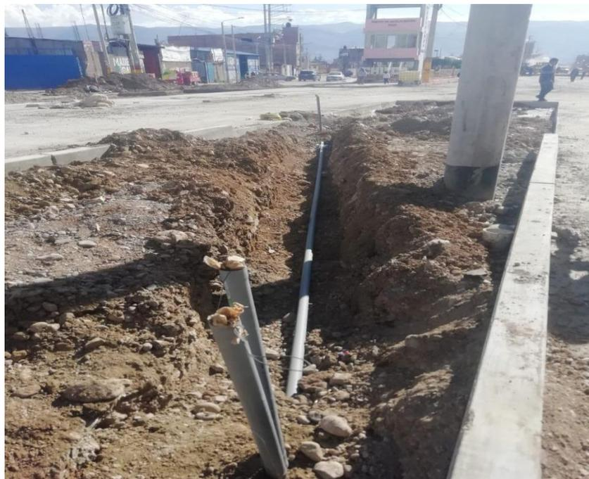
Figura 130. Excavación manual y tendido de tuberías.
