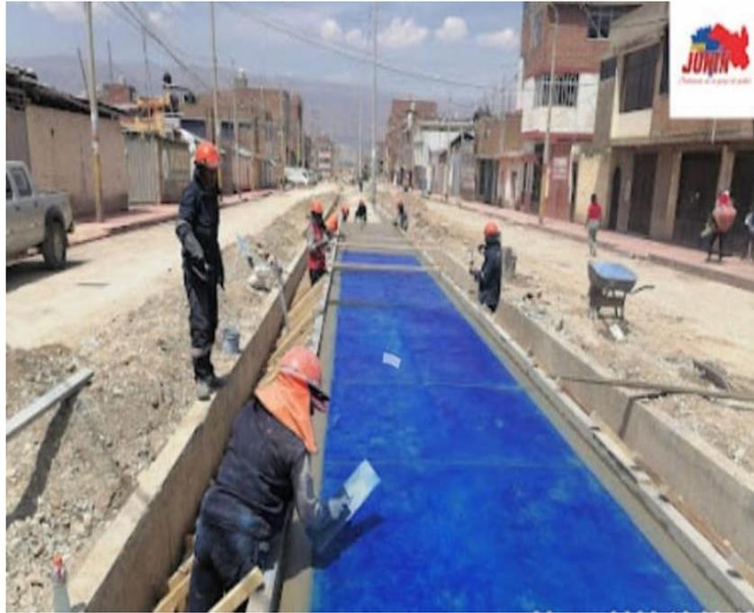
Figura 129. Acabado frotado con endurecedor azul en ciclovía
