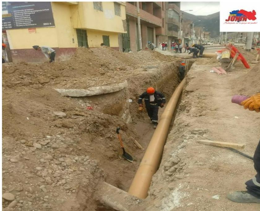
Figura 108. Instalación de tubería p/desagüe
