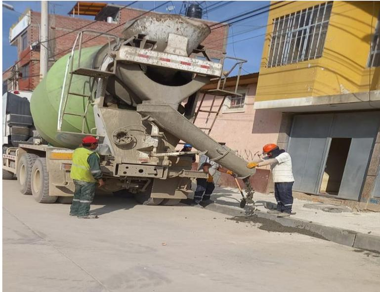
Figura 101. Vaciado de concreto  $f'c=280 \text{ kg/cm}^2$  en cunetas
