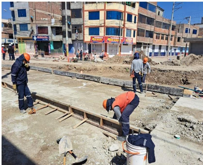
Figura 122. Encofrado de losa de pavimento
