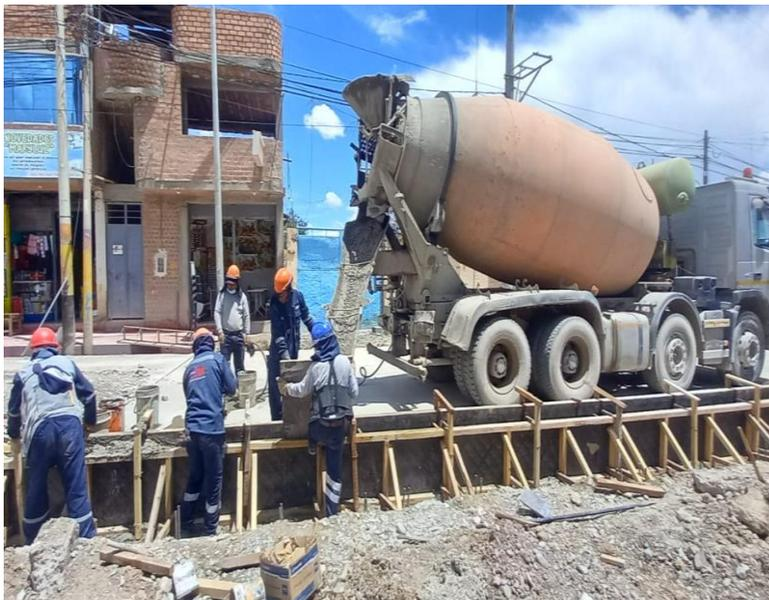
Figura 104. Vaciado de concreto  $f'c=210 \text{ kg/cm}^2$  en sardinal izquierdo
