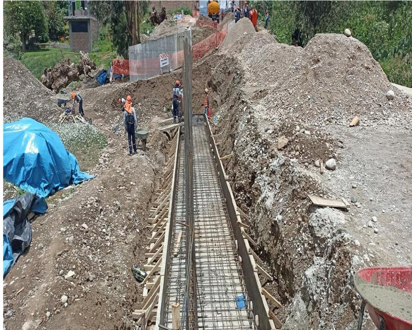
Figura 85. Distribución de aceros en muros tipo voladizo en el Jr. Gamarra
