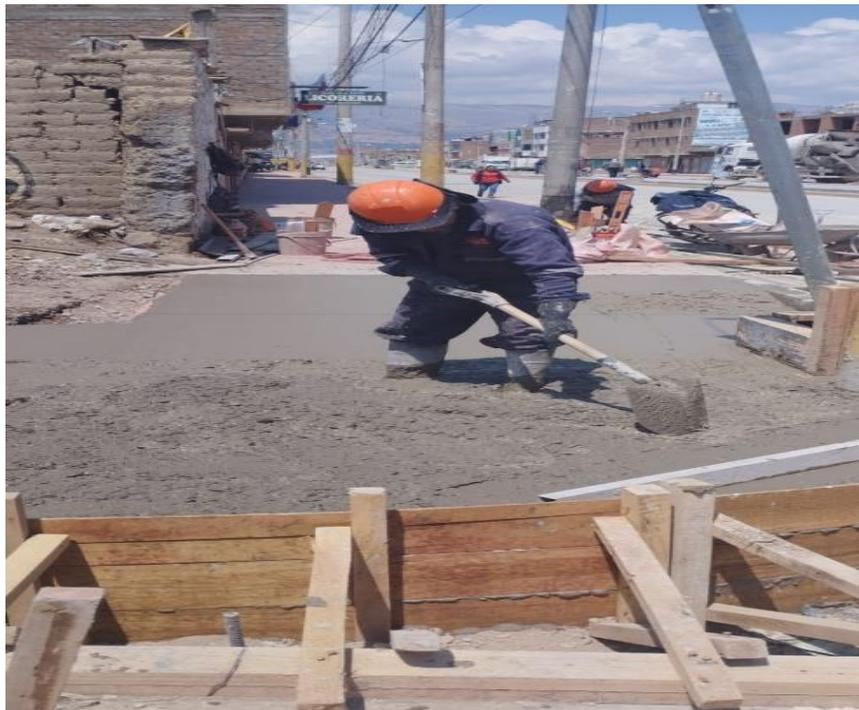
Figura 114. Vaciado de concreto  $f'c=175 \text{ kg/cm}^2$  en martillos
