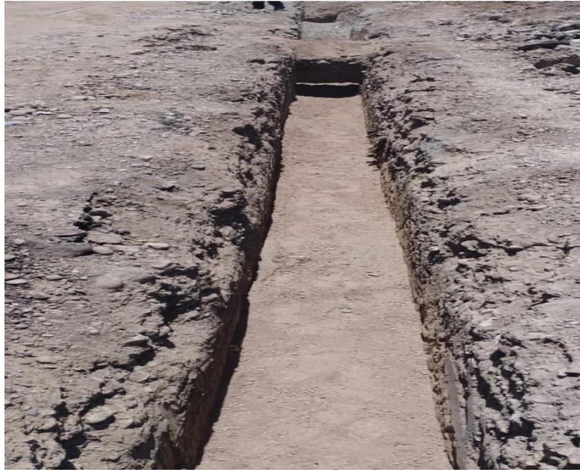
Figura 109. Relleno de zanja con material de préstamo
