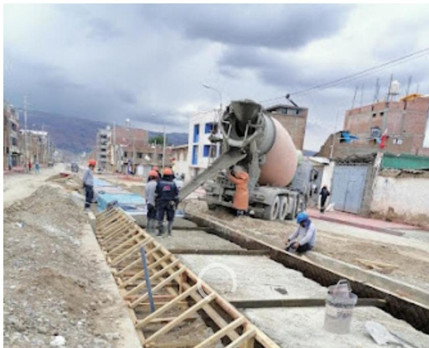
Figura 128. Vaciado de concreto  $f'c=210 \text{ kg/cm}^2$  en ciclovías
