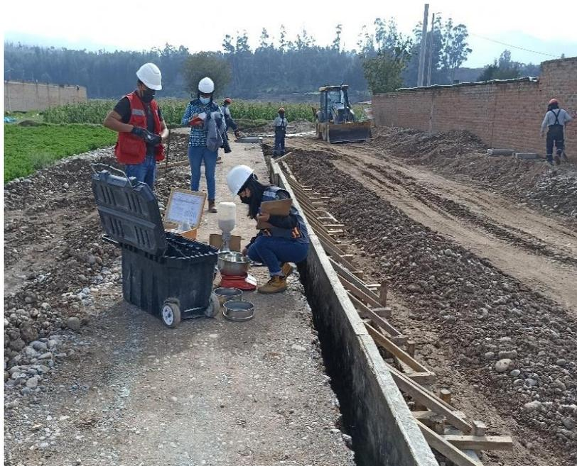
Figura 74. Pruebas de calidad a la base granular en veredas en Jr. Gamarra
