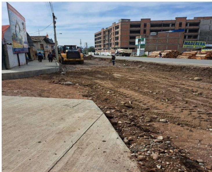
Figura 67. Corte de material suelto en el Emp. Carretera PE-3S B
