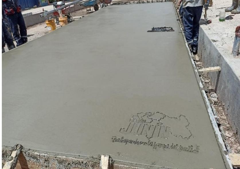
Figura 80. Acabado en losa (frotachado y barrido) con el logo del GRJ
