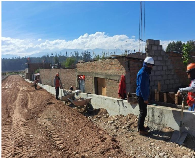
Figura 92. Relleno con material propio en los muros de contención
