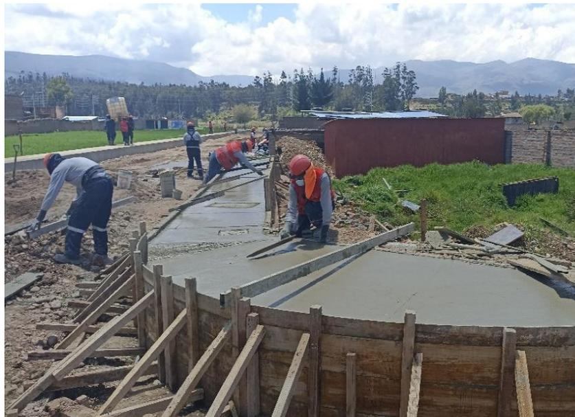
Figura 76. Vaciado de veredas y martillos con concreto  $f'c=210 \text{ kg/cm}^2$
