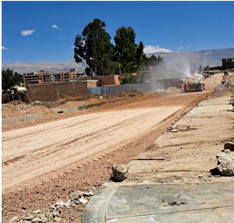
Figura 72. Humedecimiento de la base granular en el Jr. Independencia.
