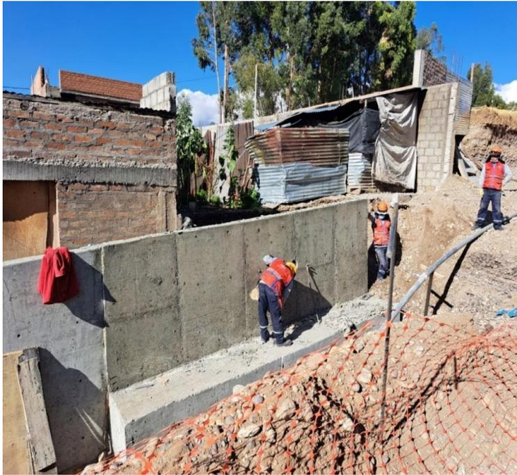
Figura 91. Muro de contención tipo voladizo terminado
