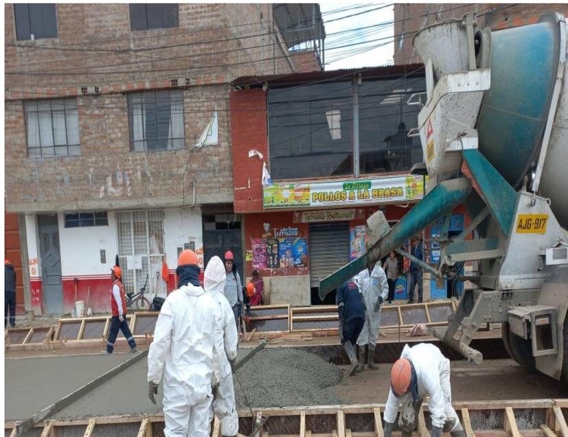
Figura 124. Vaciado de concreto  $f'c=350 \text{ kg/cm}^2$  en pavimento
