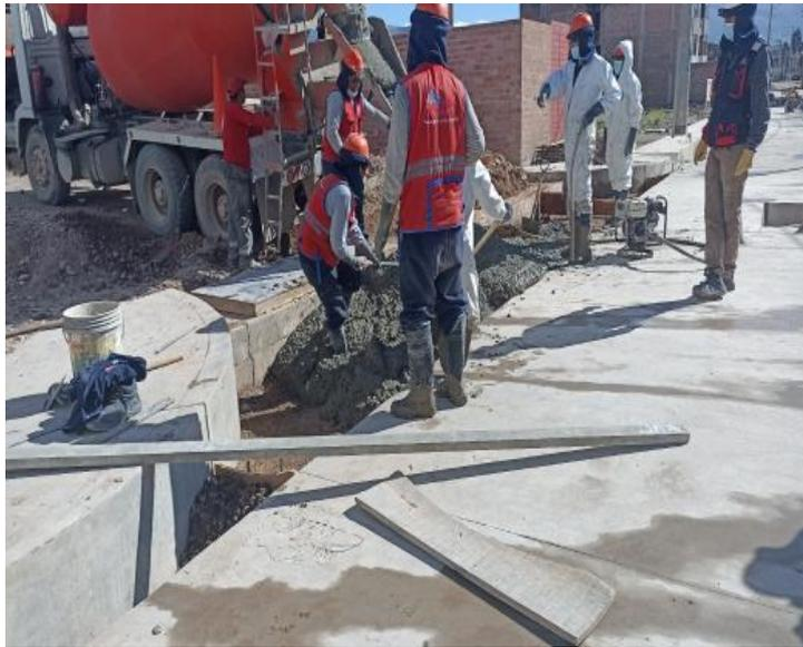
Figura 83. Vaciado de concreto  $f'c=280 \text{ kg/cm}^2$  en badenes
