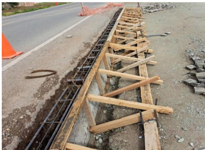
Figura 84. Encofrado del sardinel sumergido en el Emp. con PE-3S B
