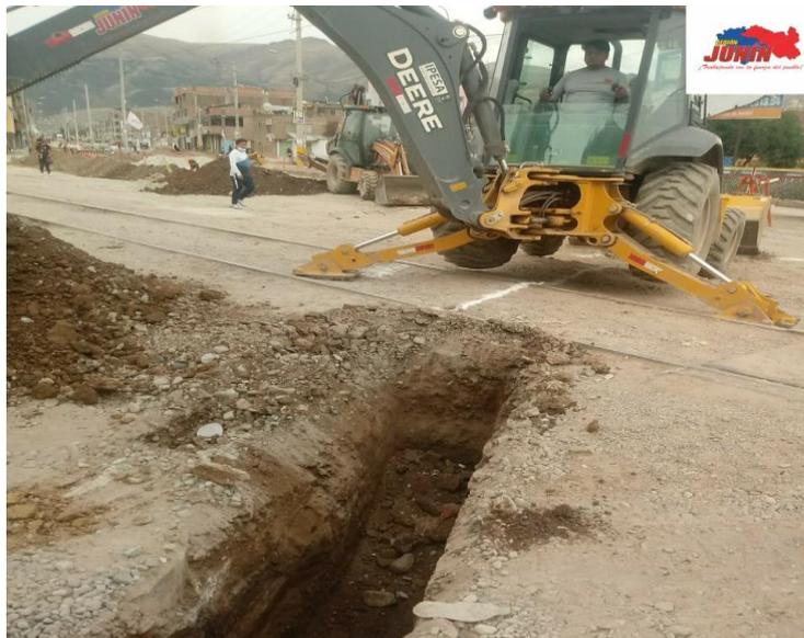
Figura 106. Excavación de zanja c/eq. Tb Dn=315 mm hasta 2.00m
