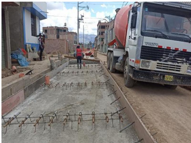
Figura 79. Vaciado de concreto premezclado  $f'c=350$ kg/cm<sup>2</sup> en losa hidráulica
