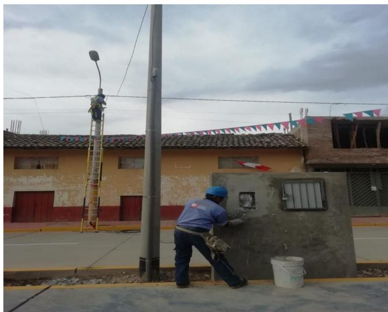
Figura 134. Acabado de murete para tableros eléctricos
