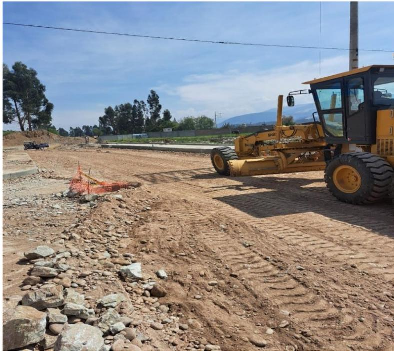
Figura 71. Colocación del material granular en el Jr. Circunvalación
