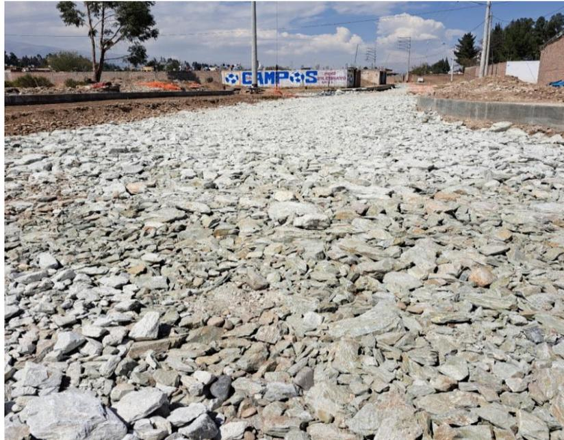
Figura 68. Sistema de drenaje con capa de pedraplén
