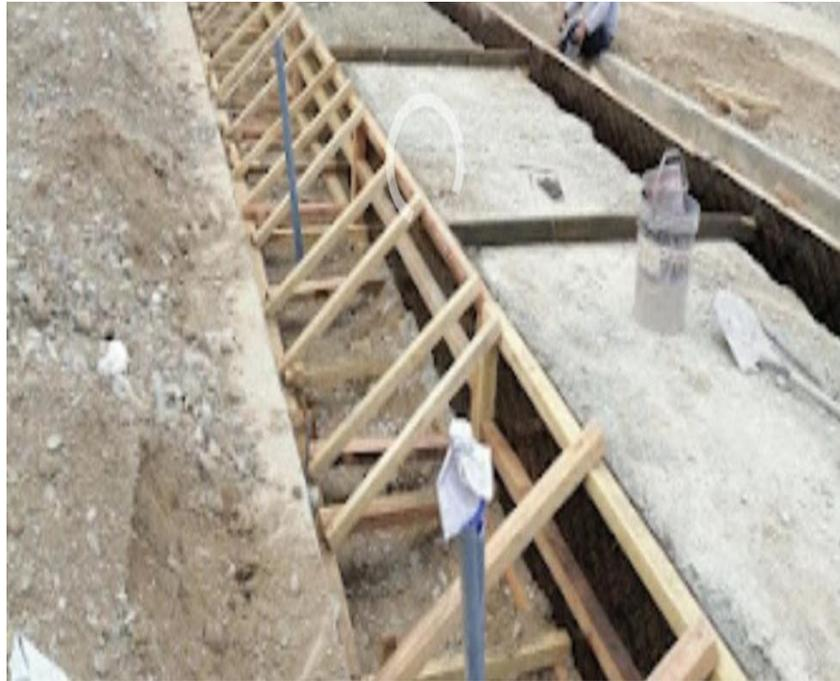
Figura 127. Encofrado de estructuras en ciclovía
