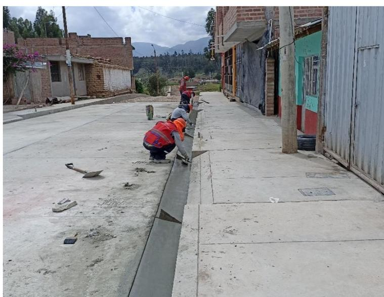
Figura 82. Acabado del concreto  $f^c=280\text{ kg/cm}^2$  en cunetas revestidas
