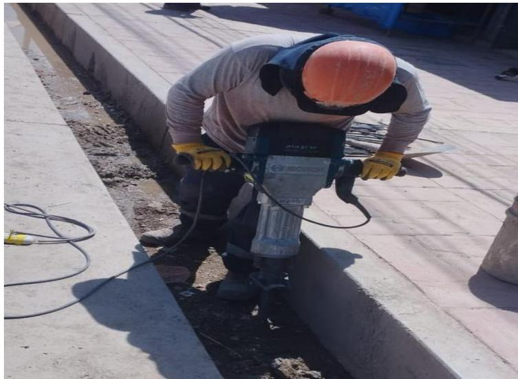
Figura 100. Perfilado de cunetas
