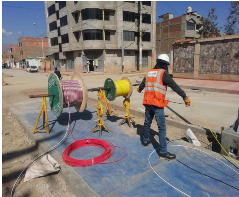
Figura 133. Cableado eléctrico para luminarias
