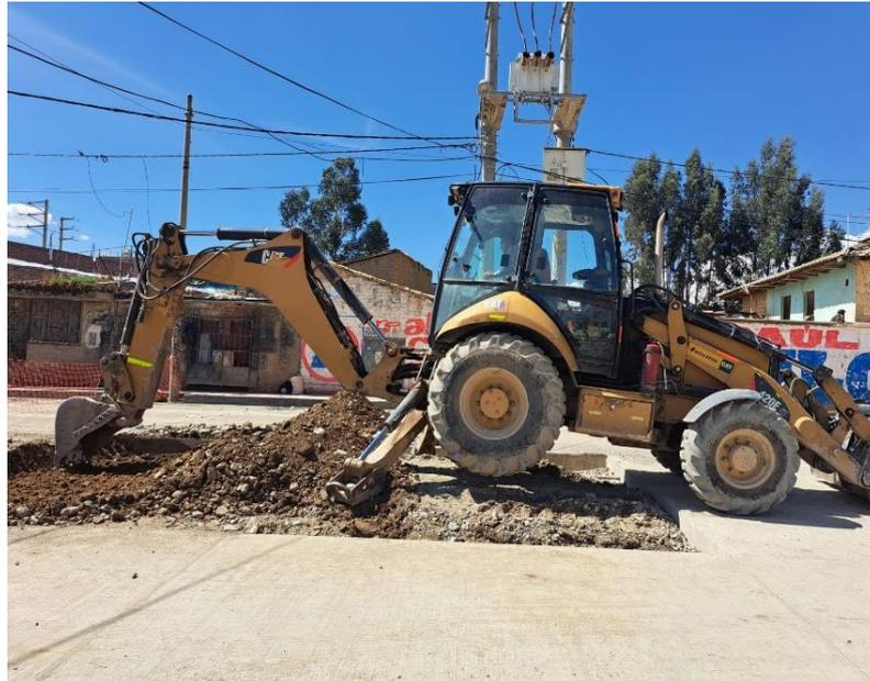
Figura 97. Perfilado a nivel de base de la calzada.
