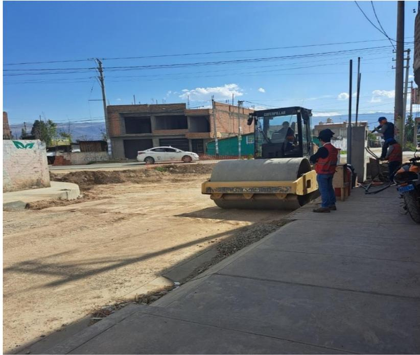
Figura 73. Compactado de base granular en el Emp. Carretera PE-3S B
