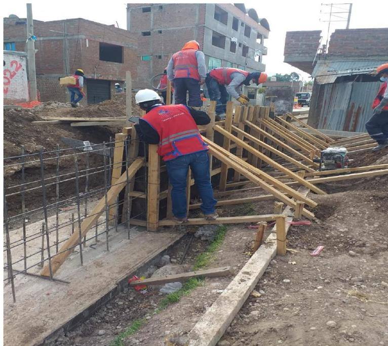
Figura 88. Verificación del encofrado de la pantalla del muro tipo voladizo en el Jr. Independencia
