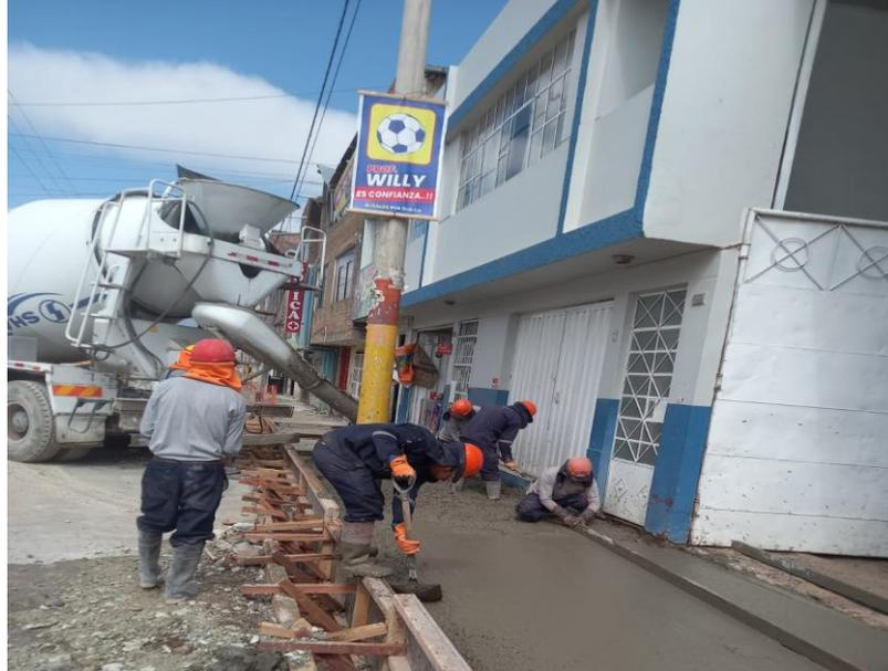
Figura 110. Vaciado de concreto  $f'c=175 \text{ kg/cm}^2$  en veredas
