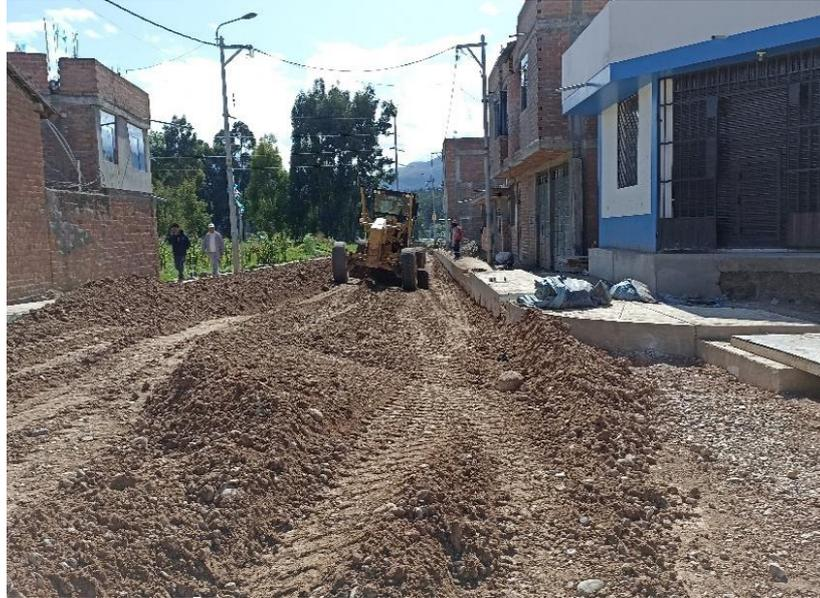
Figura 69. Compactado con material propio en Jr. Independencia.
