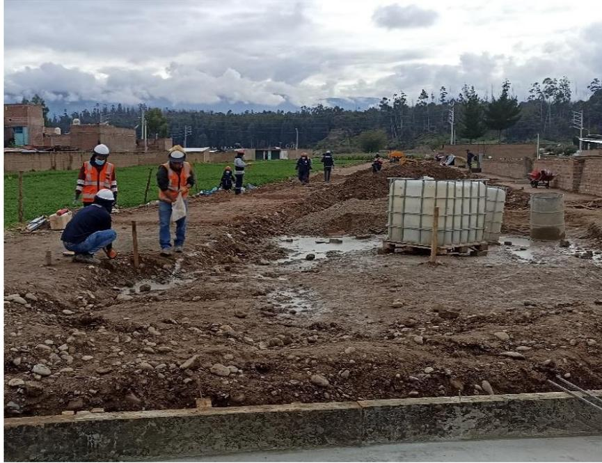
Figura 66. Trazo y replanteo de obra
