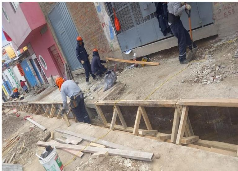
Figura 98. Perfilado de veredas, y encofrado de sardineles
