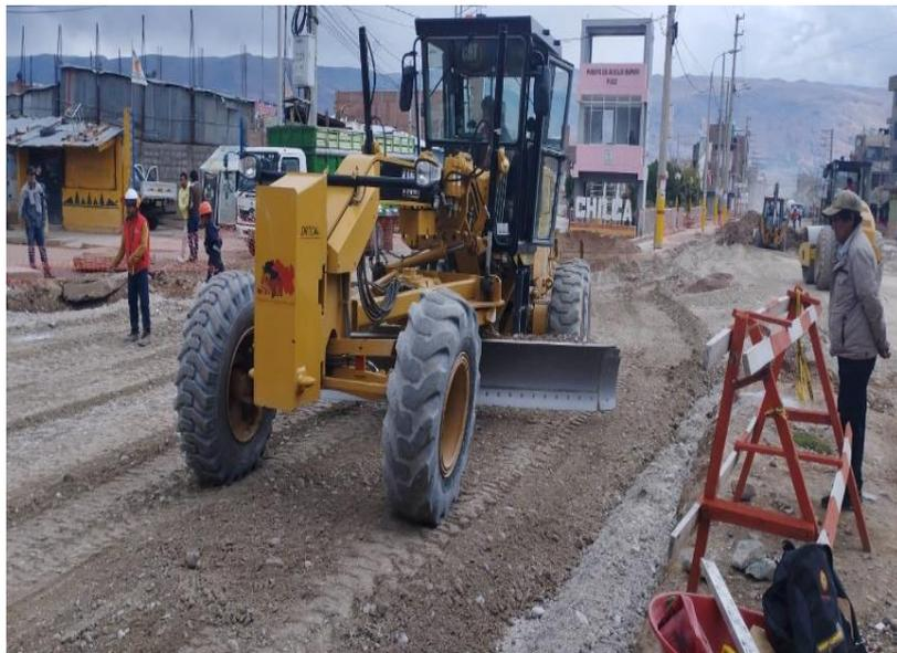
Figura 118. Extendido de base granular con motoniveladora.
