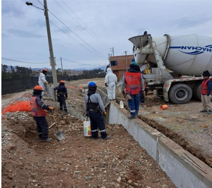
Figura 93. Ejecución de partidas de la Modificación N.º 05, vaciado de concreto premezclado  $f'c=280\text{kg/cm}^2$  en muros
