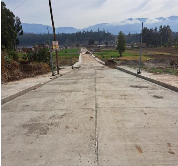
Figura 95. Vista de la losa hidráulica en Jr. Gamarra terminado.
