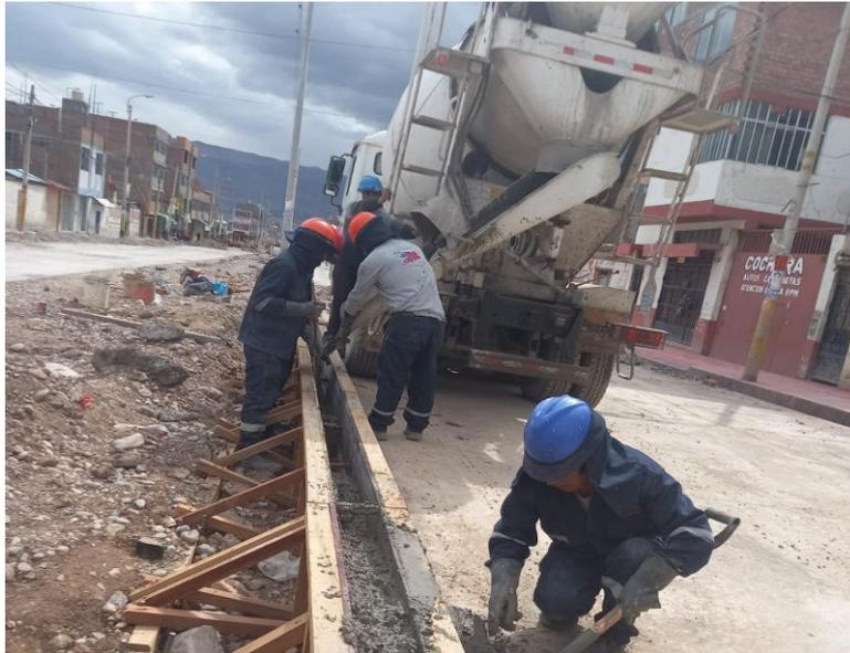
Figura 103. Vaciado de concreto  $f'c= 210 \text{ kg/cm}^2$  en sardineles derecho
