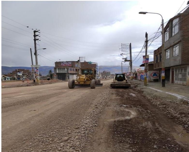
Figura 117. Corte y conformación de base para pavimento
