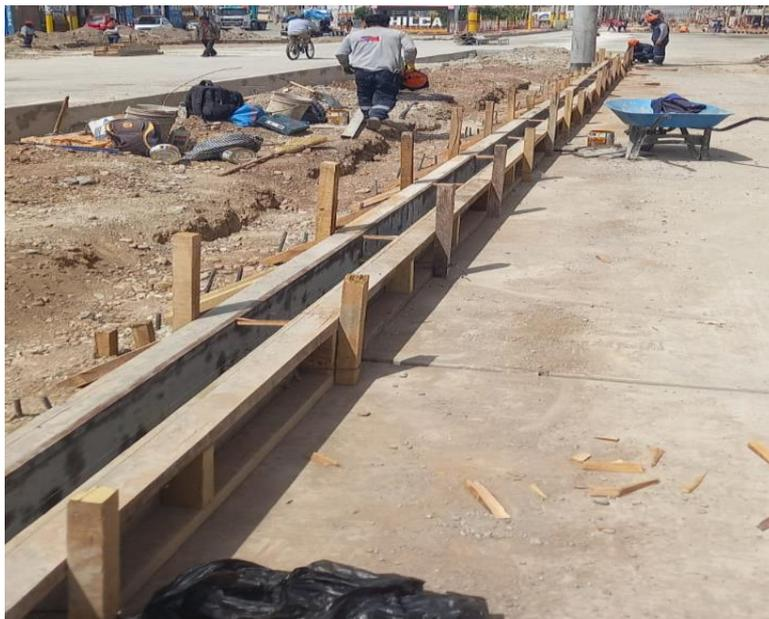
Figura 102. Encofrado de sardinel central para ciclovía
