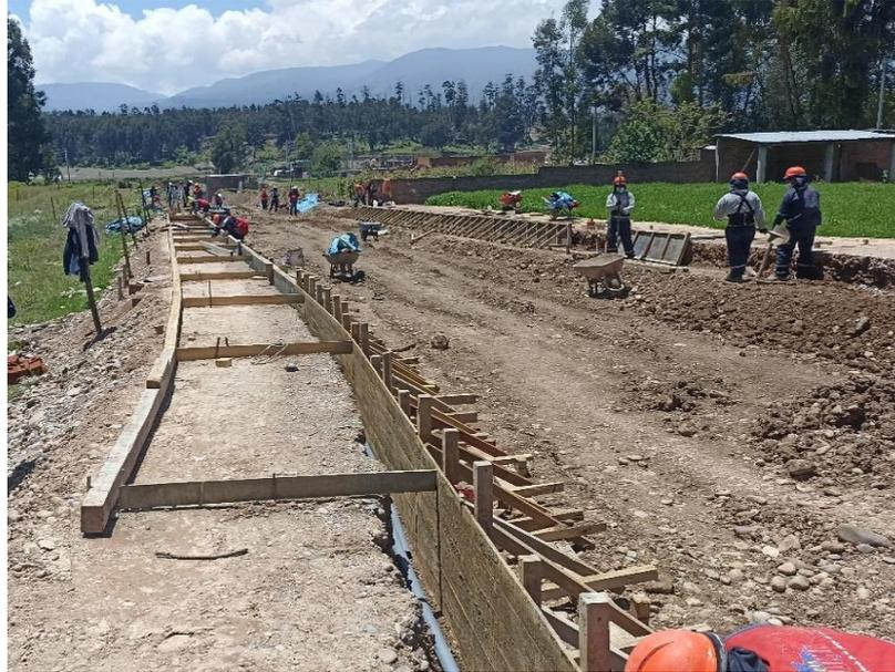
Figura 75. Encofrado y desencofrado para estructuras.
