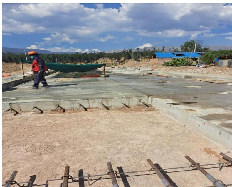
Figura 81. Curado de la losa hidráulica
