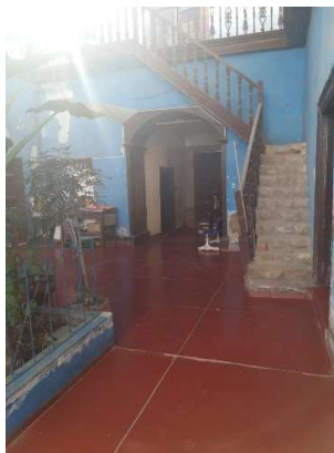
Figura 35. Escalera ubicada en patio. Nota: Elaboración propia.
