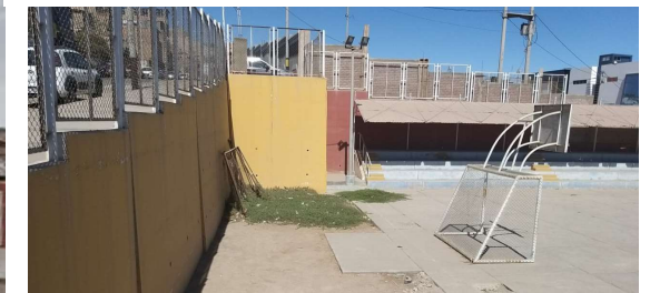
Figura 52. Vista Calle Amazonas. Nota: Elaboración propia.
