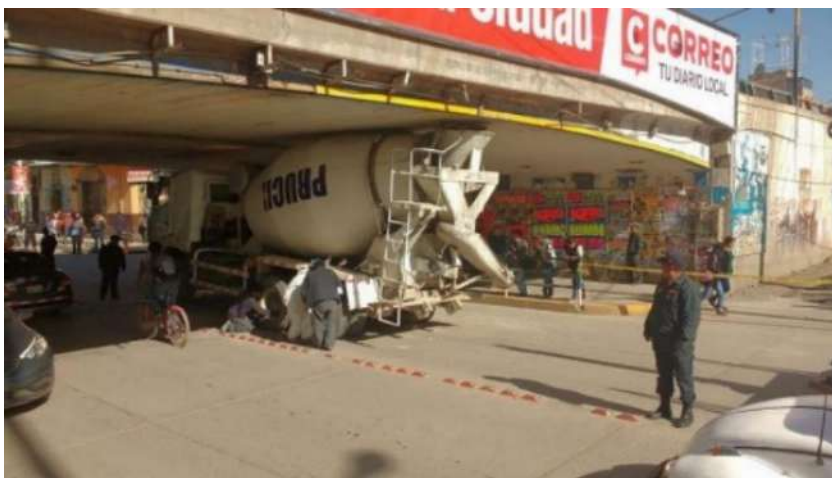
Figura 29. Accidente de tránsito en 2018 en el puente Giráldez Tomada de Junior Meza en el diario El Comercio
