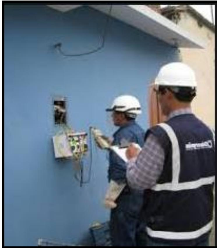
*Figura 7. Inspección de medidor con patrón GFUVE*
