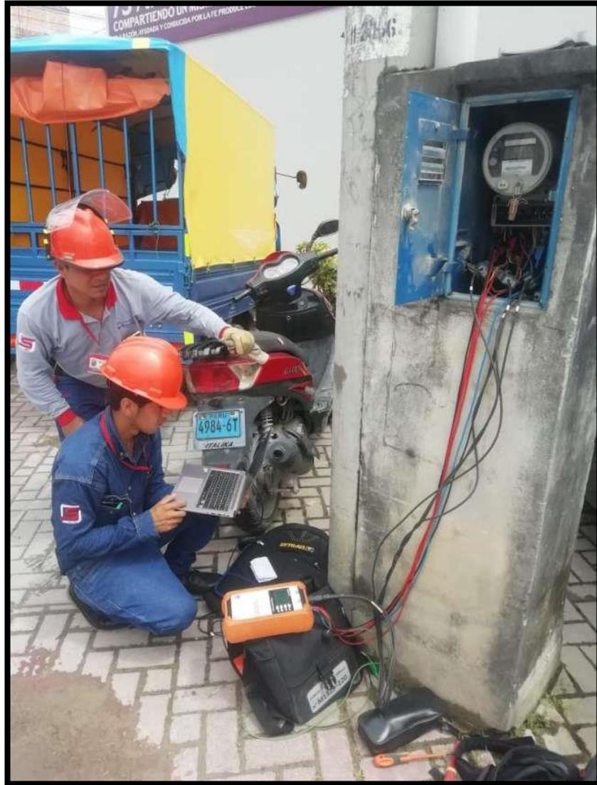
**Figura 4. Inspección de medidor con patrón radian**
