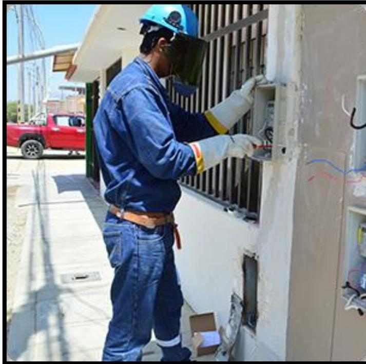
*Figura 9. Desarrollo de la inspección del medidor con patrón GFUVE*
