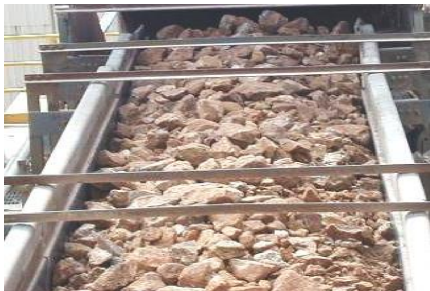
Figura 30. Faja transportadora 2 Fuente: Manual de operaciones de chancado
