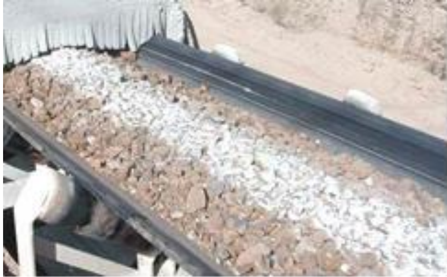
Figura 31. Faja transportadora 5 Fuente: Manual de operaciones de chancado
