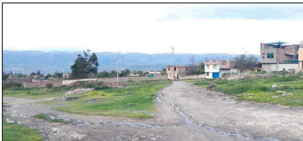
El piso usado como caminería y vía que atraviesa el terreno es el mismo terreno natural con erosiones por la humedad en muy mal estado.
