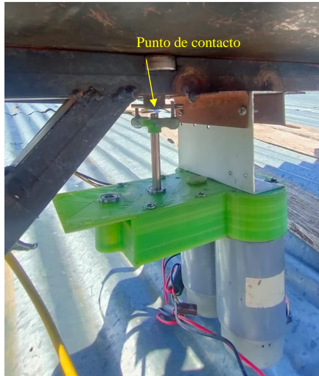
Figura 71. Instalación del multiplicador de velocidad a la turbina.
