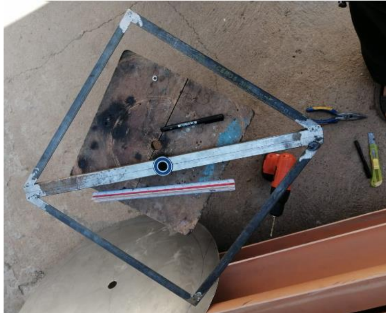
Figura 61. Construcción de la base de turbina
