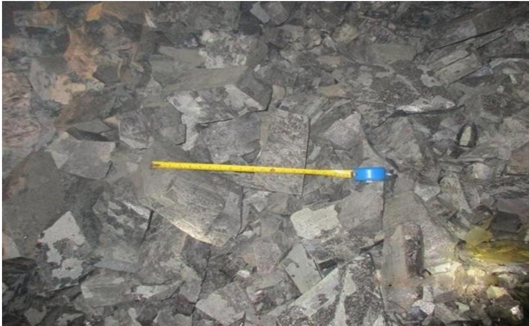
Figura 31. Material post voladura, escenario anterior. Tomada del departamento de Planeamiento
