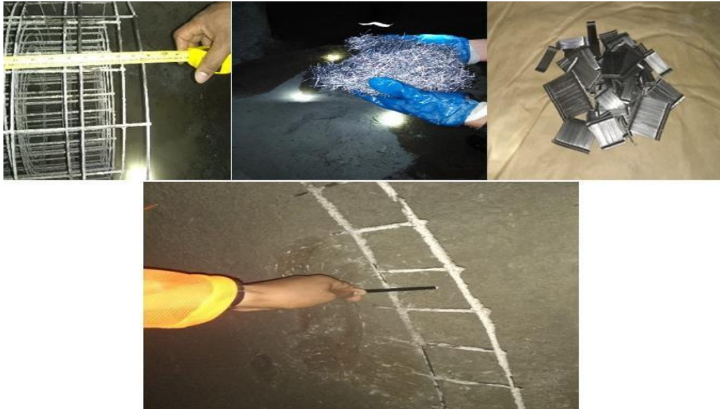
Figura 14. Refuerzos del shotcrete Tomada de información brindada por la empresa
