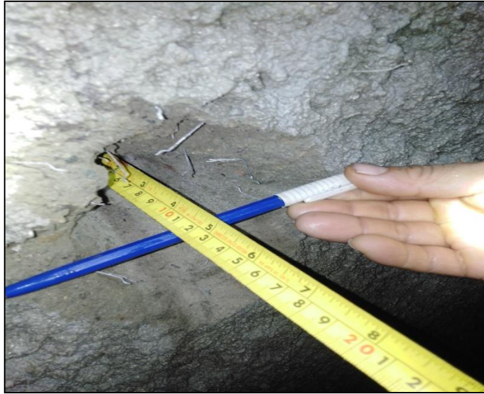
Figura 11. Control de espesor de la capa de shotcrete Tomada de información brindada por la empresa
