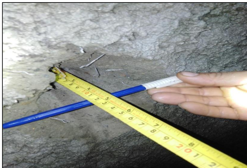
Figura 15. Control de espesor Tomada de información brindada por la empresa
