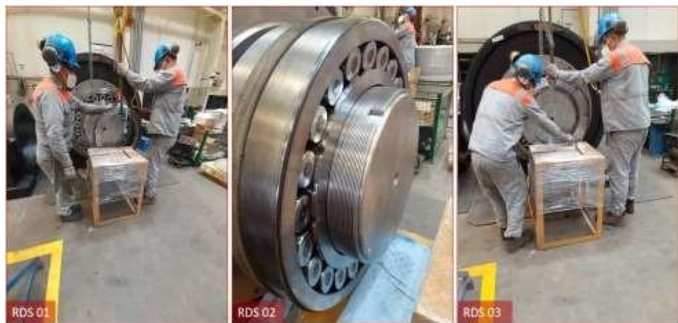
Figura 103. Montaje de tuerca de fijación Nota. Reporte de montaje de rodamientos (19)
