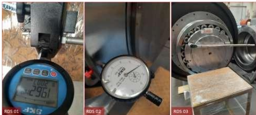
Figura 99. Montaje de tuerca de fijación Nota. Reporte de montaje de rodamientos (19)
