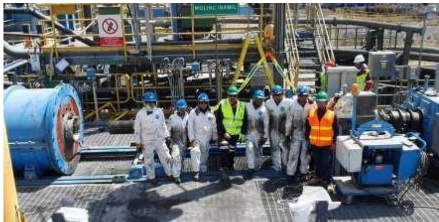
Figura 5. Servicio de montaje de rodamientos en Isamill.
