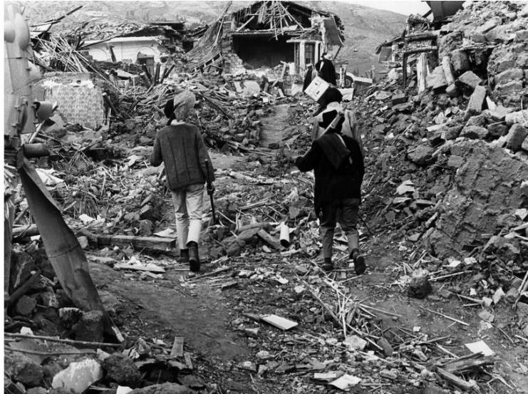
Figura 1. Efectos del terremoto de 1970
