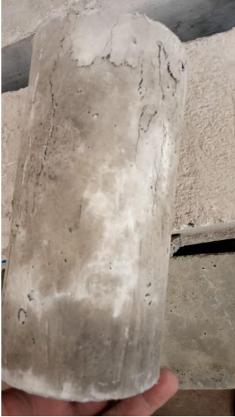
Rotura de probeta de concreto con adición de 450 g/m 3 de microfibra de polipropileno
