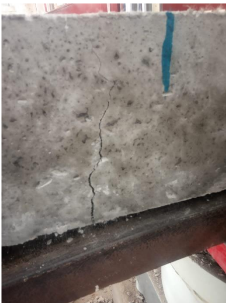
Rotura de viga de concreto con adición de 4500 g/m 3 de microfibra de polipropileno
