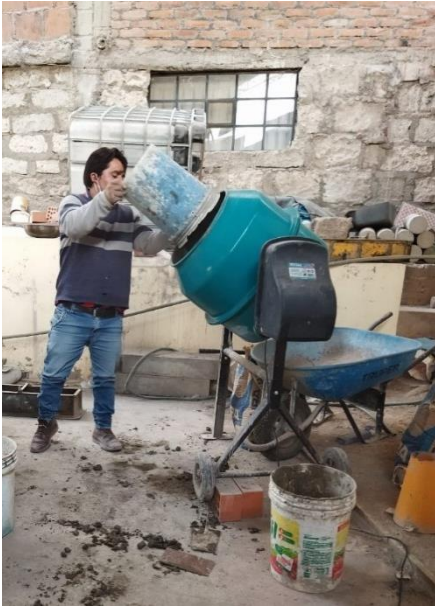
Elaboración del Concreto
