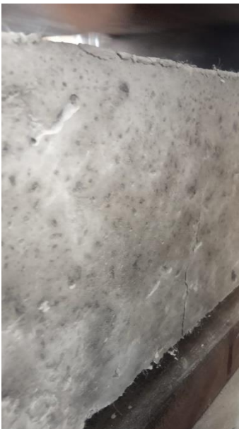
Rotura de viga de concreto con adición de 1200 g/m 3 de microfibras de polipropileno
