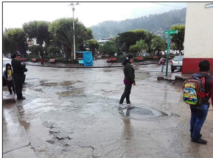
Imposibilidad de paso peatonal causada por lluvias intensas.
