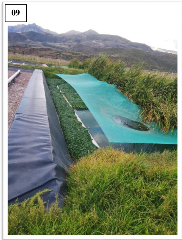
Fotografía N° 09. Humedales artificiales N° 01 y 02.
