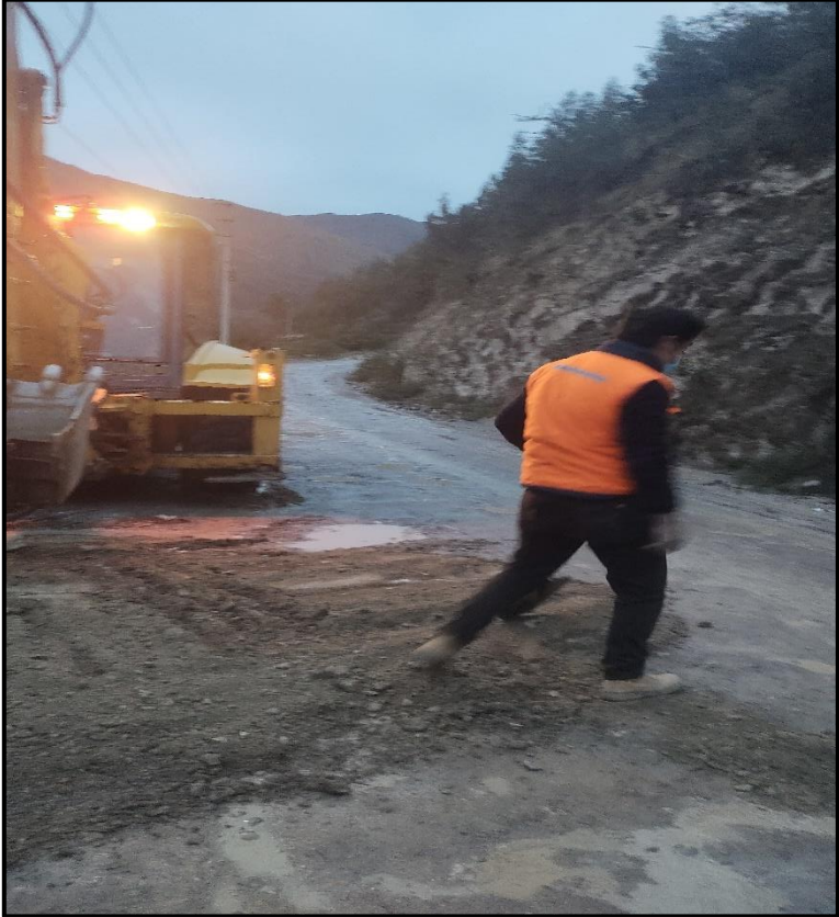
Retrato12: Tapada de la calicata para no dejar con riesgo la vía
