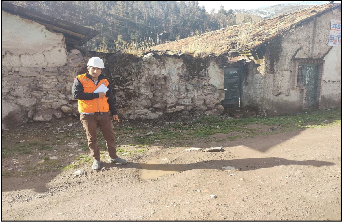
Retrato06: Ubicación de falla en el afirmado
