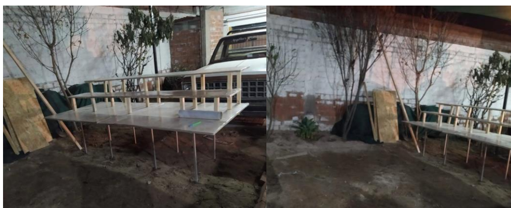
Figura 7. Construcción de estructura de soporte para el sistema de tratamiento, 2021.
