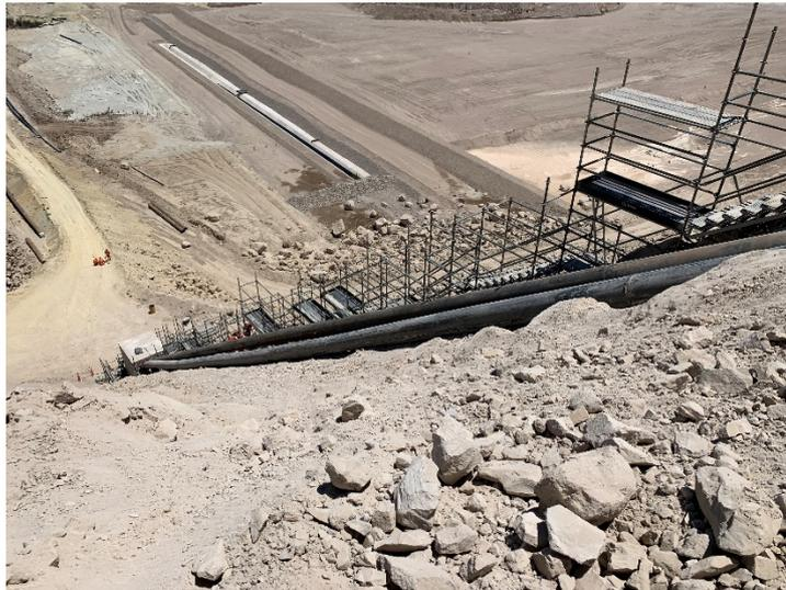
Figura 41. Tubería instalada en talud sin acceso vehicular
