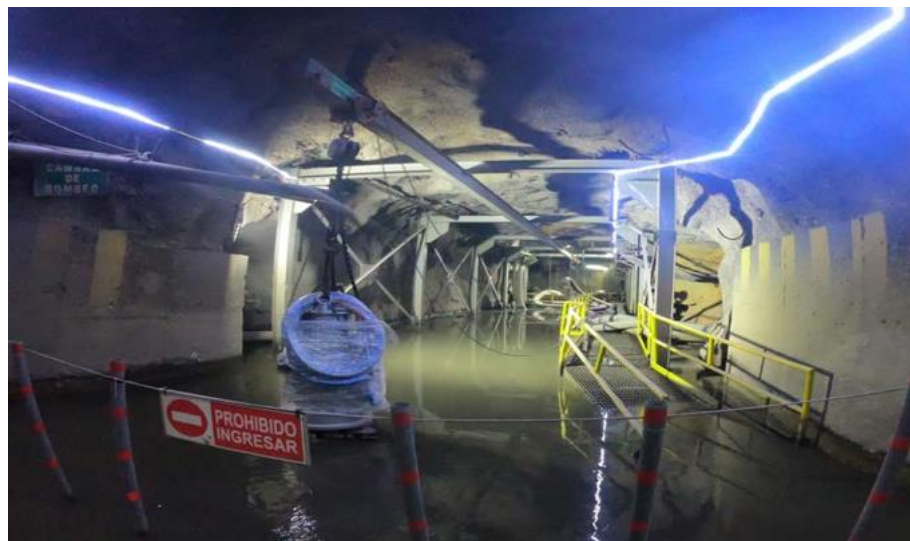
Figura 9. Condición de labor de trabajo en época de lluvia
