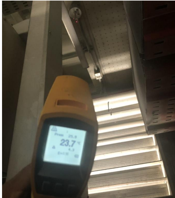
Figura 38. Inspección de dispositivos de detección en el motivator #2.
