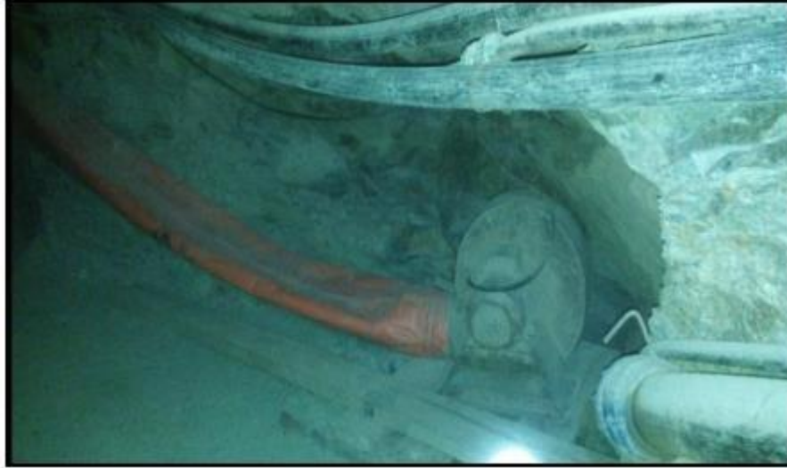
Figura 2. Ventilación interior mina GI 520. Fuente: MACDESA
