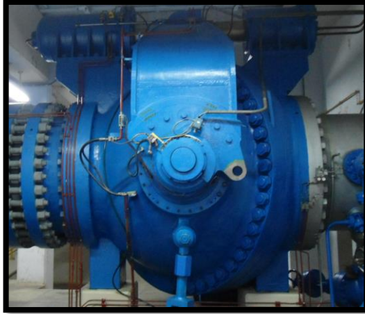
Figura 5: Válvula Esférica SAM.
