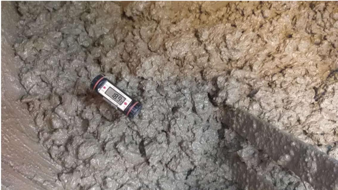
**FOTO N° 06:** control de temperatura del concreto.
