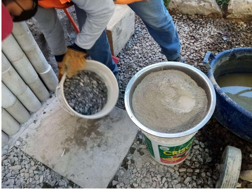
**FOTO N° 05:** dosificación de agregado fino y agregado grueso.
