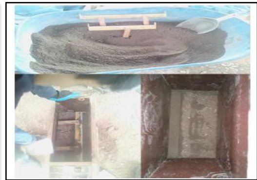
Ilustración 28 Preparación del mortero y construcción de hiladas en las juntas del tapial, tomado de Chuqui Paucar, Wilfredo y Chalco Ruelas, Ronal Augusto.
