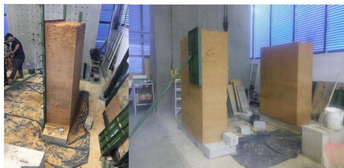
Ilustración 2 Muros desencofrados y terminados
