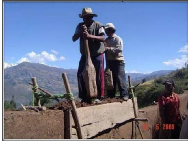
Ilustración 46 Construcción cerco de tapial
