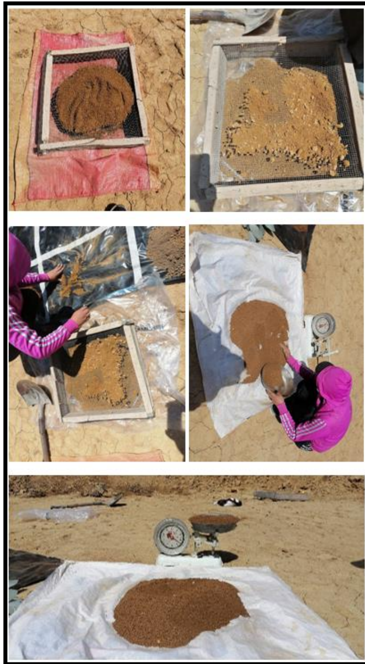
Ilustración 64 Detalle del proceso del cernido de tierra
