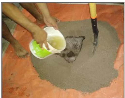
Ilustración 13 Preparación de mezcla para tapial, tomado de Ruiz Catillo, Mirela y Bringas Segura, Aldo
