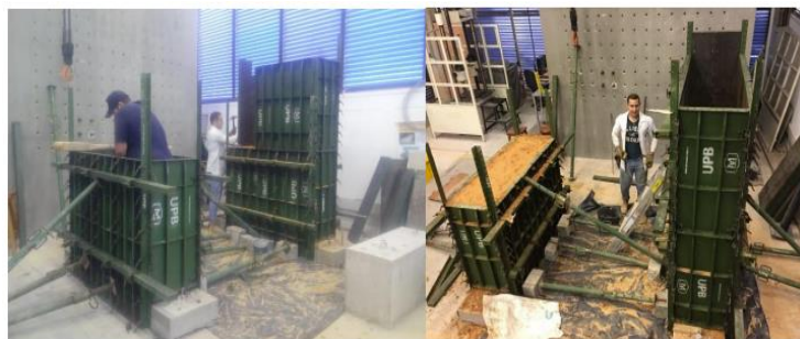
Ilustración 1 Armado de formaleta y construcción del Muro A y Muro B.
