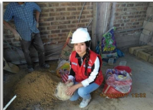
Ilustración 19 Elaboración de adobes compactados con adición de fibra de maguey, tomado de Salazar Terrones, Leslye Lizzeth.
