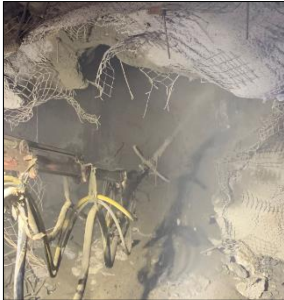
Figura 43. Lanzado de shotcrete para controlar la labor SN_274
