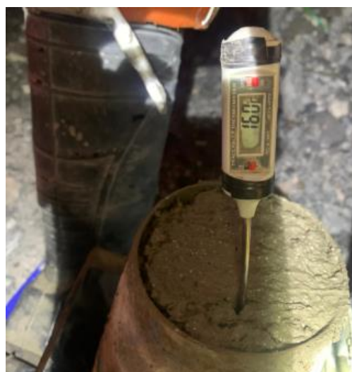
Figura 41. Medición de la temperatura del concreto
