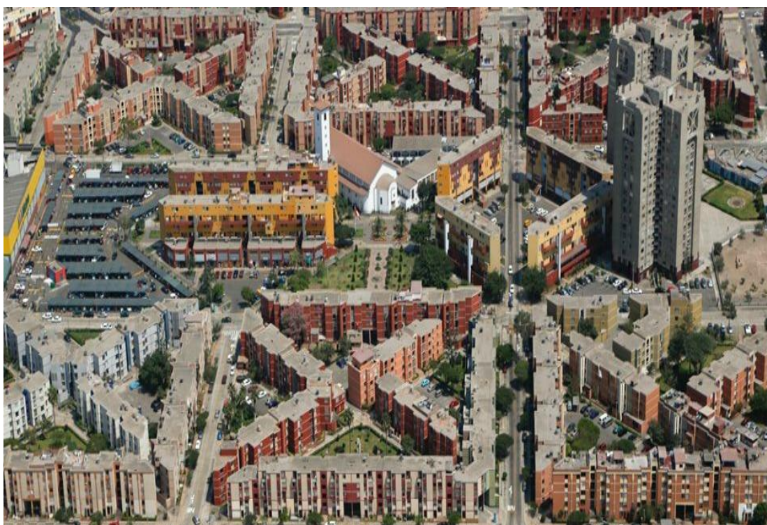
Figura 9. Vista aérea de las Torres de Limatambo
