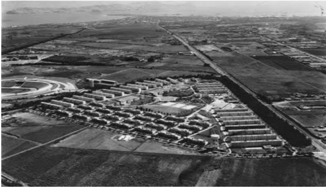
Figura 6. Vista aérea de la Unidad Vecinal N°3.
