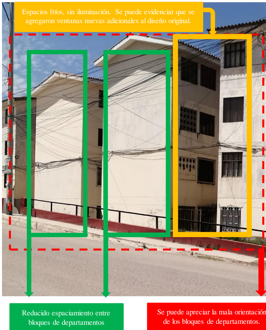
Figura 16 Mala orientación de los bloques de dptos.
