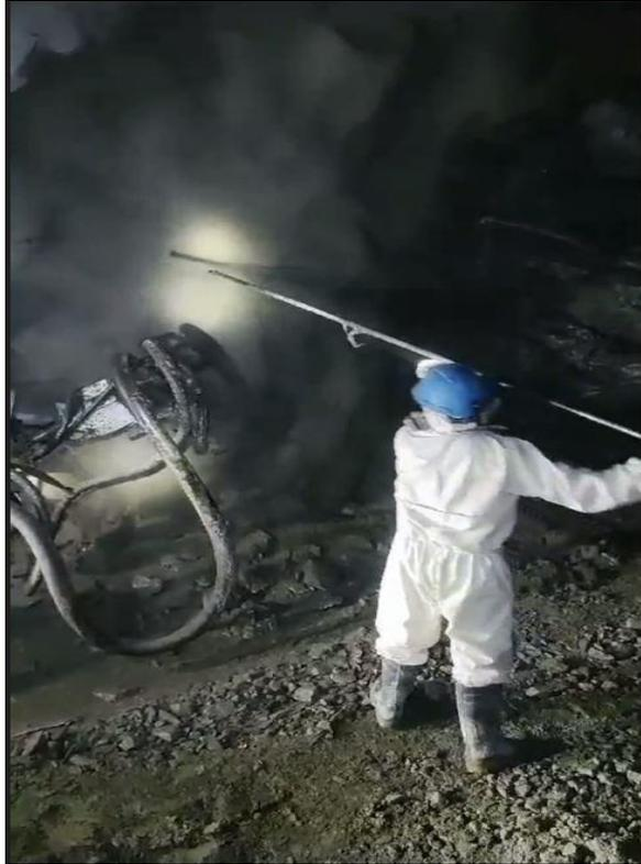
**Figura 9. Colocado de calibradores, control espesor de shotcrete, Cx 2713, Nv 1565**
