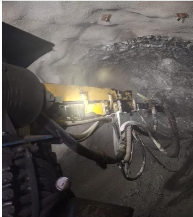
**Figura 7. Lanzado de shotcrete, Cx 2713, Nv 1565**
